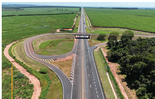
Dispositivo de retorno remodelado, no km 60+400, entre Américo Brasiliense e Santa Lúcia.
