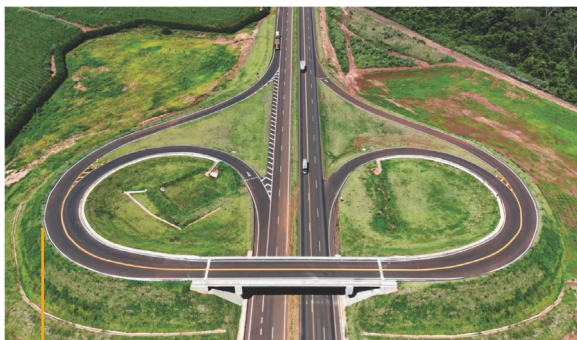
Dispositivo de retorno construído no km 56+900, que dará ainda mais segurança aos usuários.
