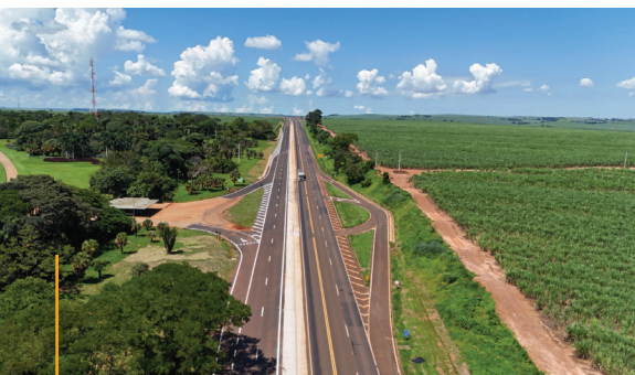
Trecho da rodovia SP-255, no km 63+100, próximo ao município de Américo Brasiliense.
