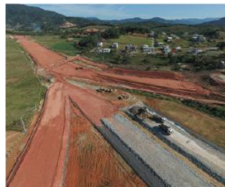
Registro das obras de construção do futuro trevo de interseção do Contorno com a SC-407, em Biguaçu. Um dos pontos onde será possível acessar a nova rodovia.
