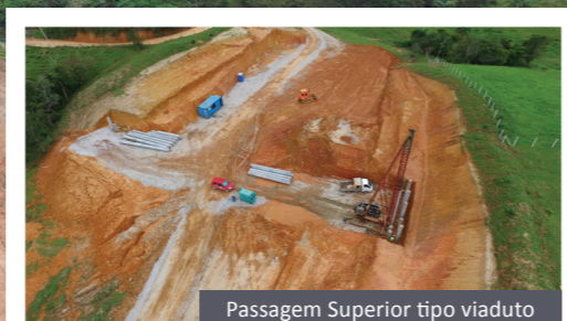
Passagem Superior tipo viaduto
