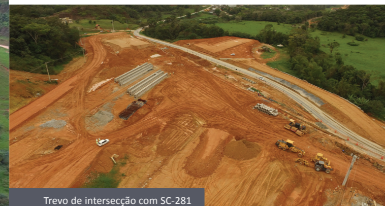
Trevo de intersecção com SC-281
