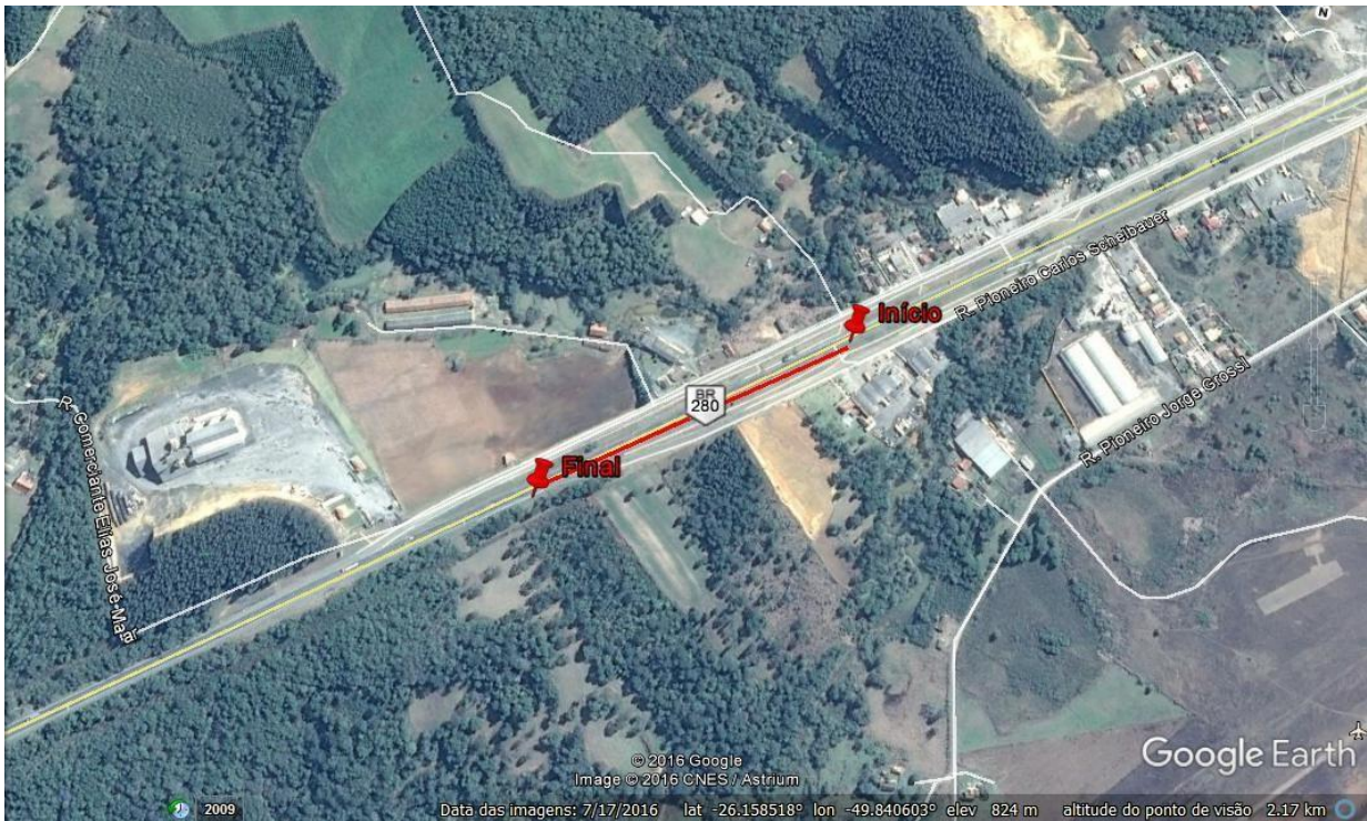
Figura 1: Localização trecho 1 (km 007+185 ao km 008+060 S).
