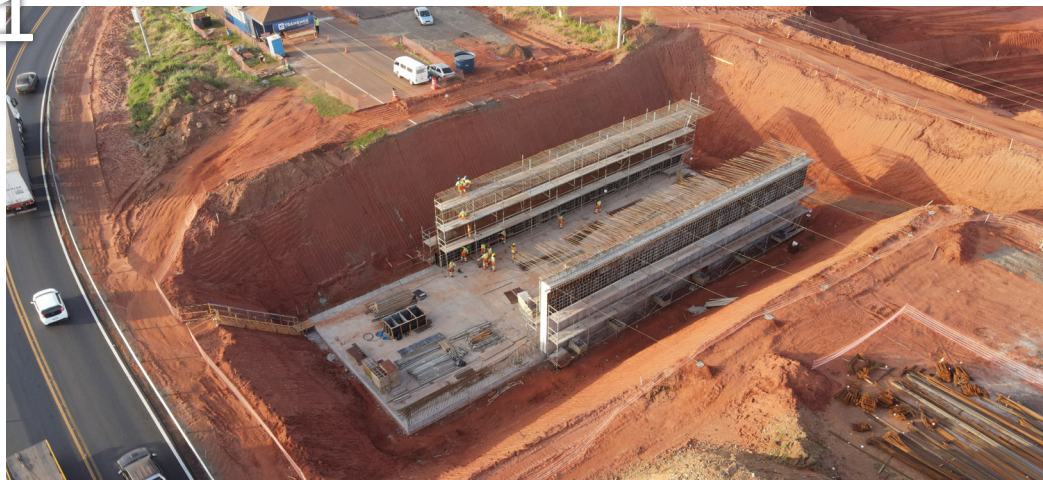
Dispositivo do km 167+670
