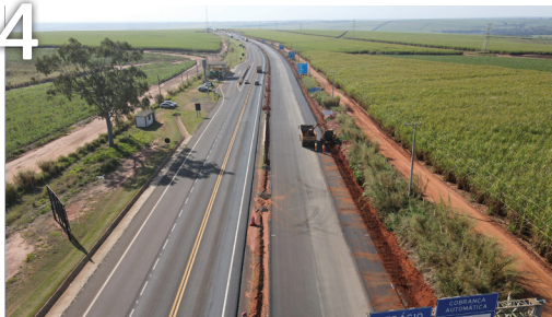
Trecho do km 166+500
