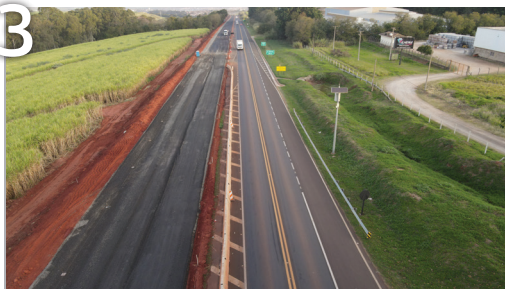
Trecho do km 168+500 ao km 170
