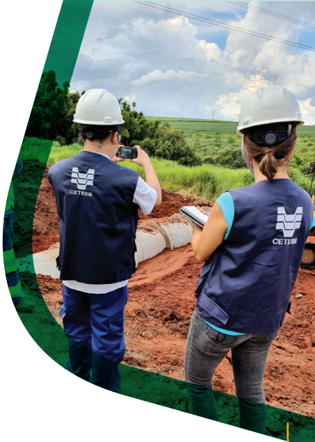
Técnicos da Cetesb visitam frentes de obras
