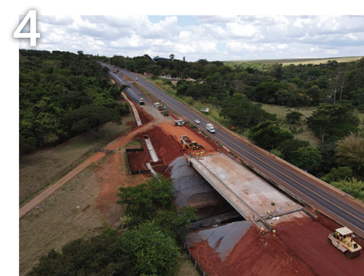
Pontes do km 144
