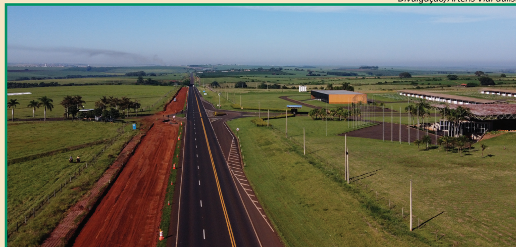
Projeto prevê menor impacto ambiental e trará maior segurança na rodovia
