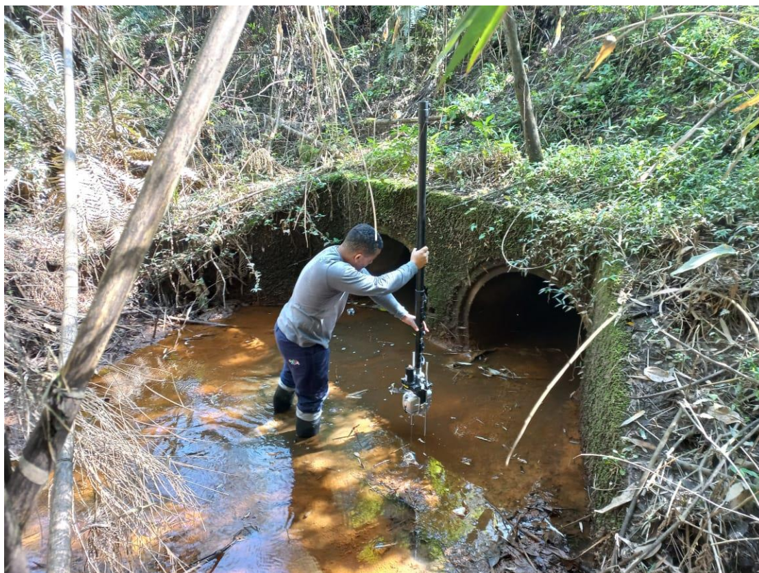
Figura 3.7 - Local de trabalho para inspeção a montante da tubulação
