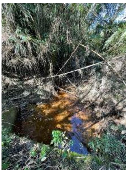
Figura 3.10 - Vegetação à Montante da Tubulação.
