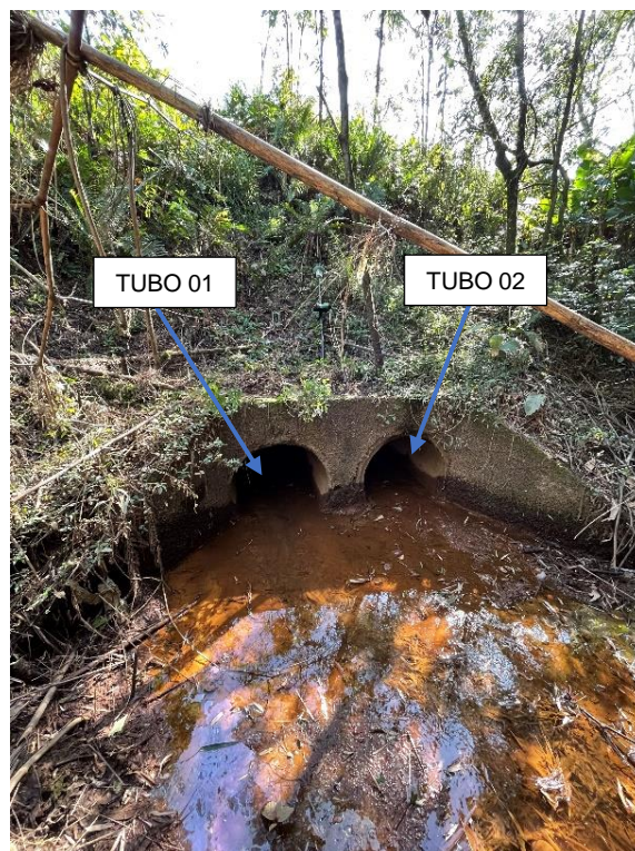
Figura 3.9 - Dispositivo de entrada da tubulação a montante
