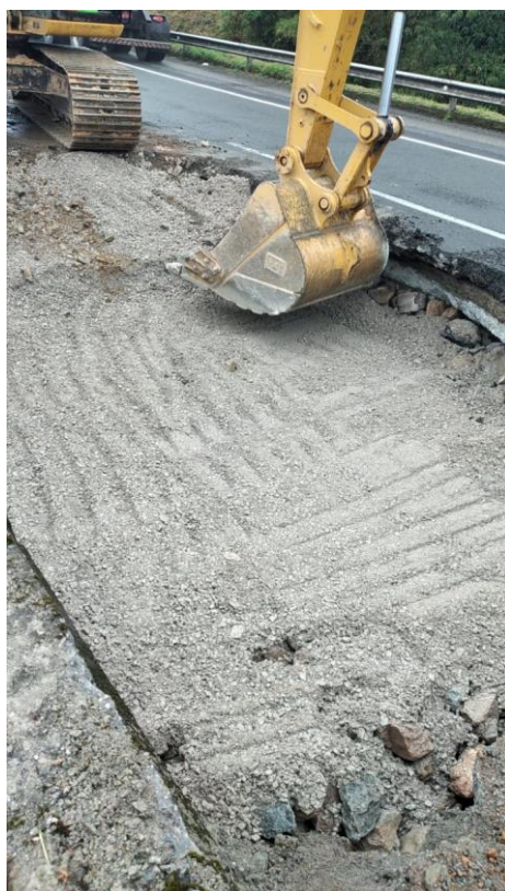
Figura 3.5 - Recomposição das camadas do pavimento
