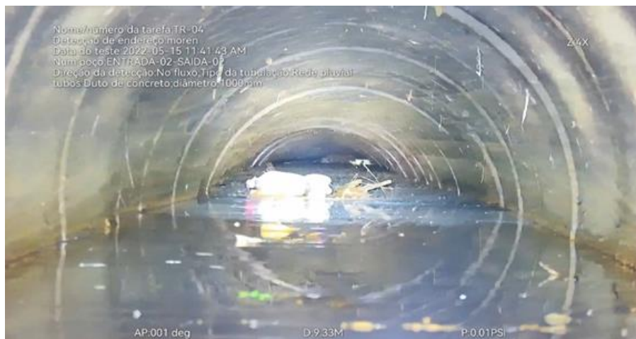
Figura 3.13 - Início da inspeção da tubulação 02 - montante.
