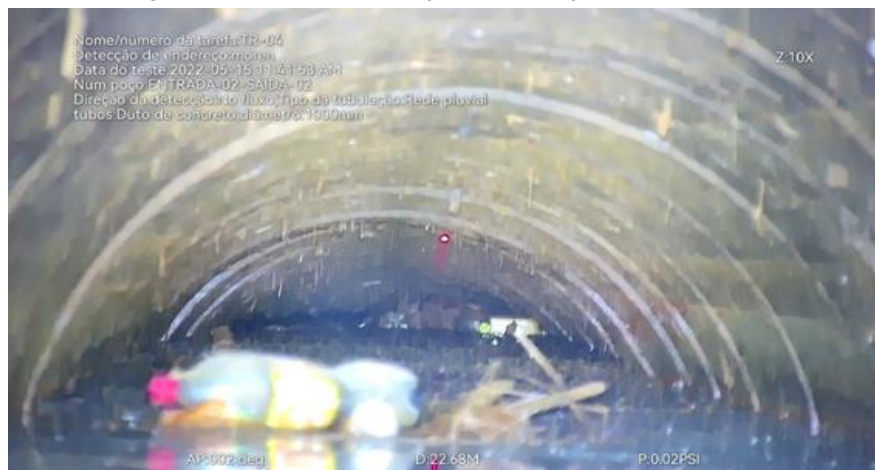
Figura 3.14 - Alcance máximo no Tubo 02 à montante.
