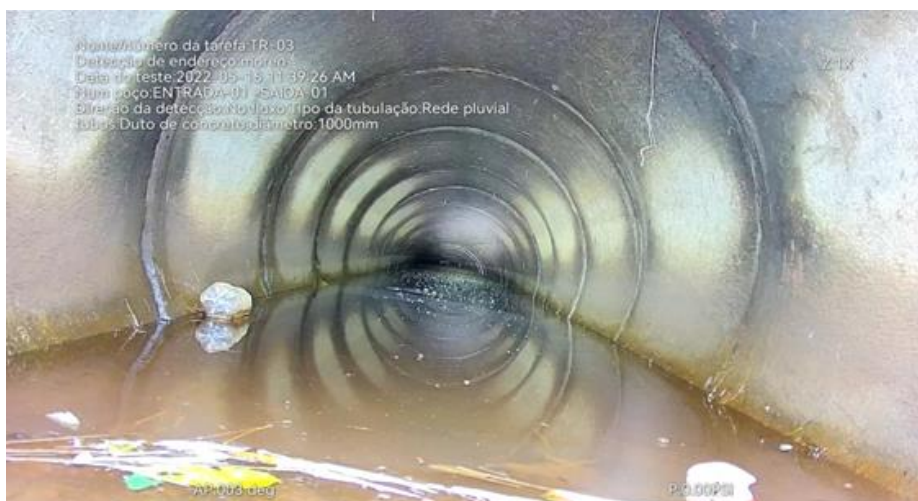
Figura 3.11 - Início da inspeção da tubulação 01 - montante.
