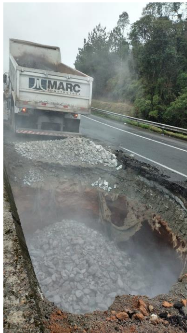
Figura 3.4 - Preenchimento do buraco aberto com Rachão
