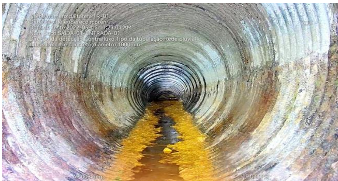
Figura 3.17 - Vista da Jusante do Tubo 01.
