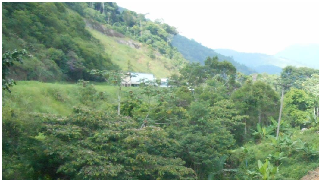
Foto 4 - Vista do local, a partir da nova pista em fase de implantação, onde será implantado o retorno operacional.
