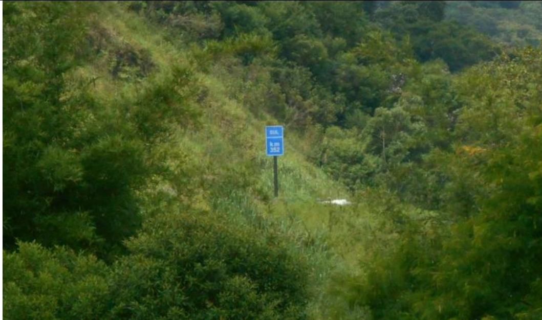
Foto 3 - Vista do local, a partir da nova pista em fase de implantação, onde será implantado o retorno operacional ( indicação do km 352 ).
