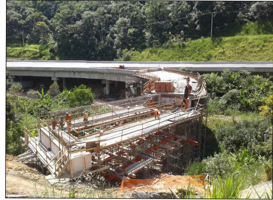
FOTO 07: MODIFICAÇÃO DA SUPERESTRUTURA
