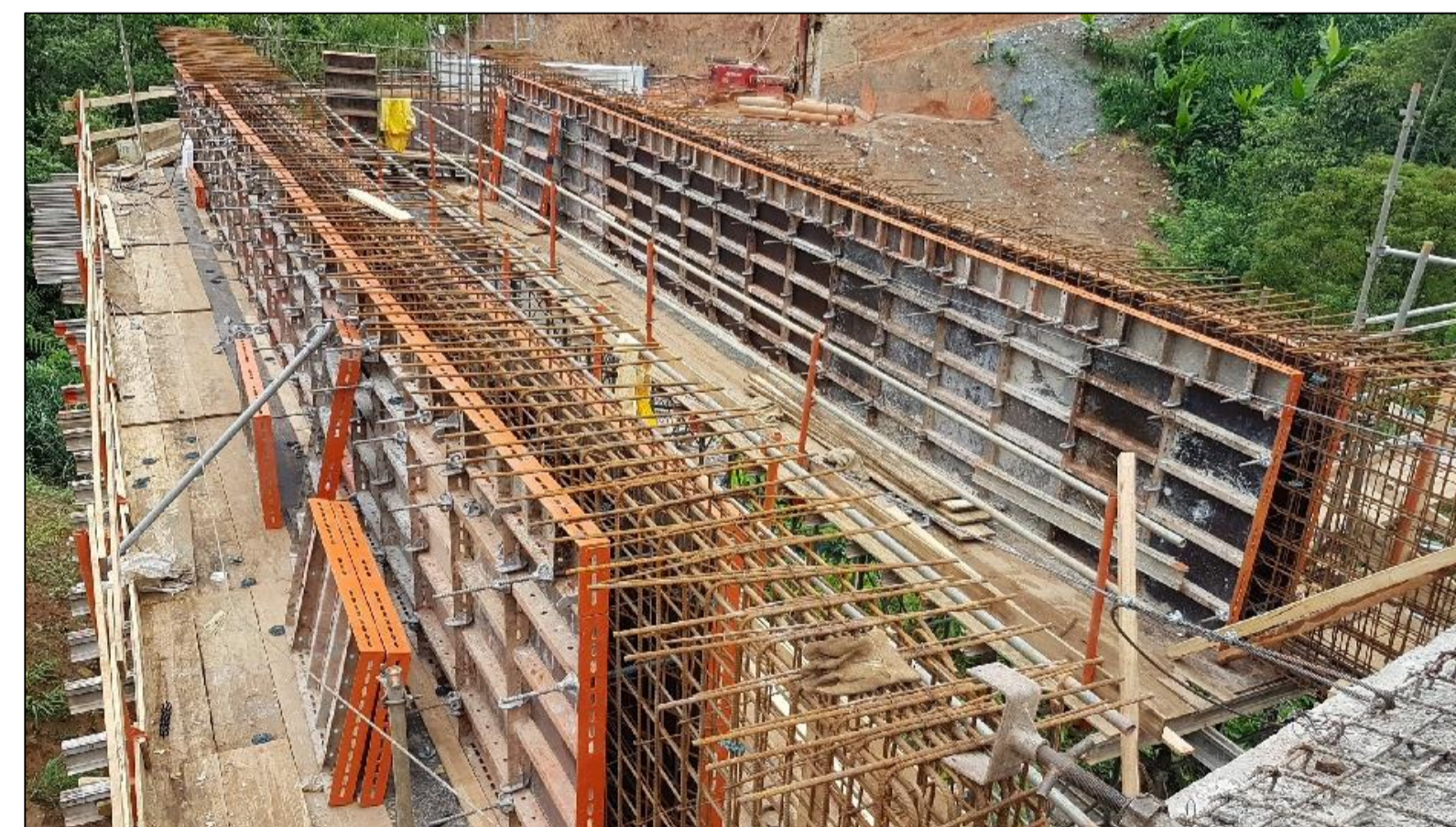
FOTO 05: MODIFICAÇÃO DA SUPERESTRUTURA
