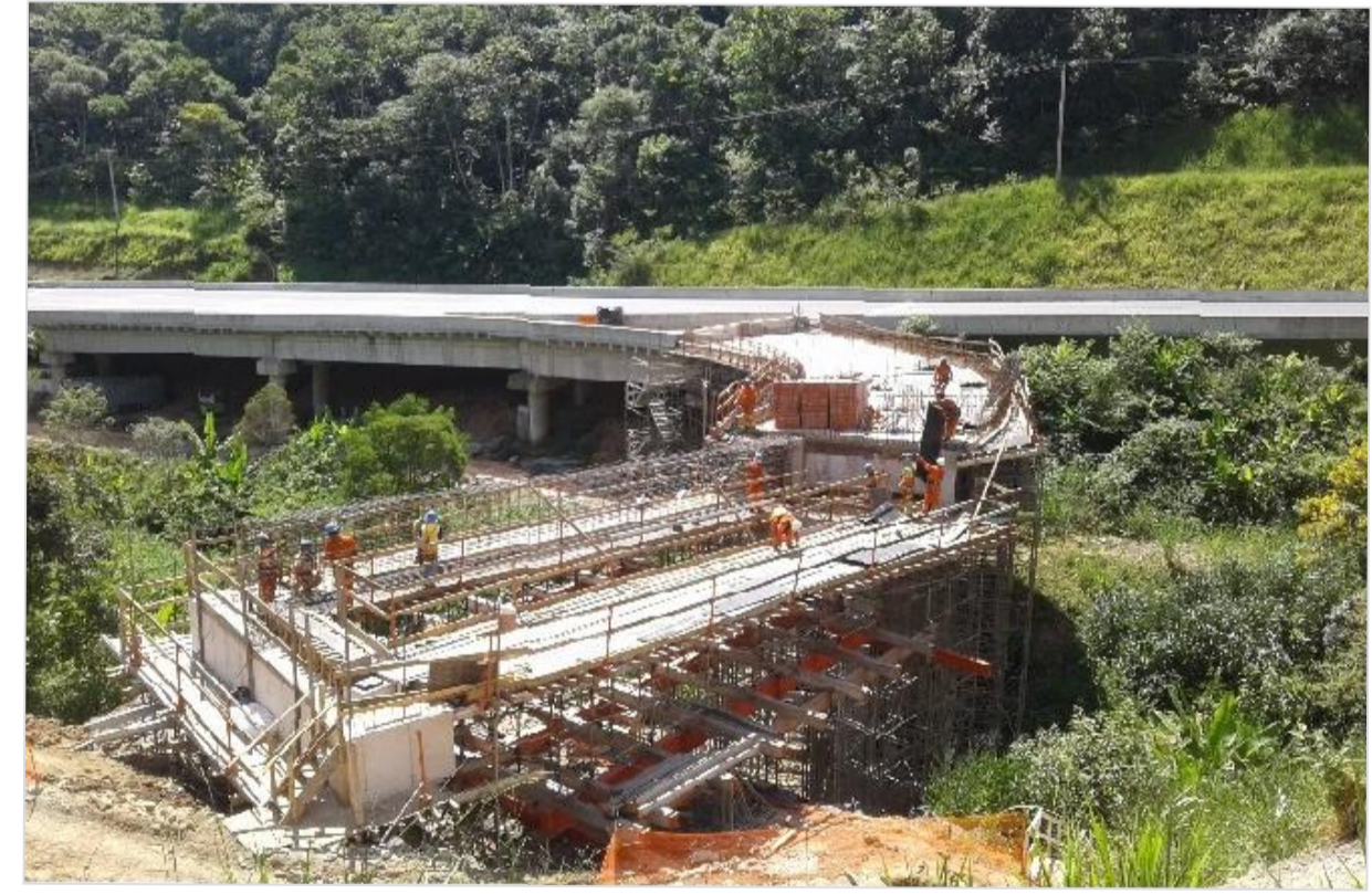
FOTO 02: MODIFICAÇÃO DA SUPERESTRUTURA
