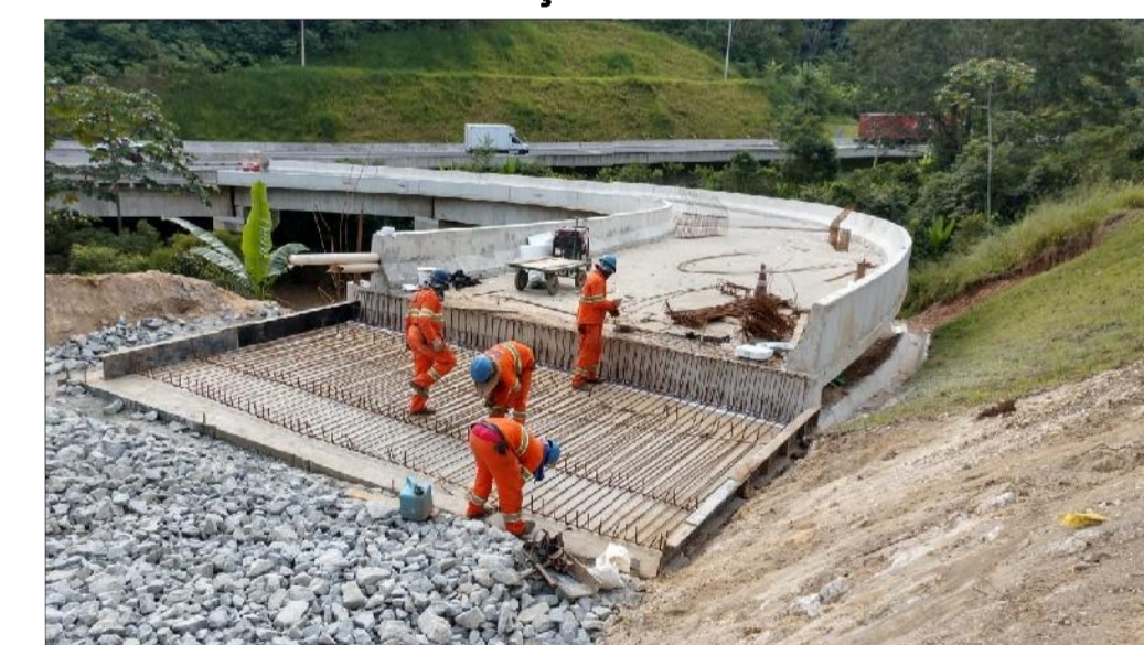
FOTO 11: MODIFICAÇÃO DA SUPERESTRUTURA
