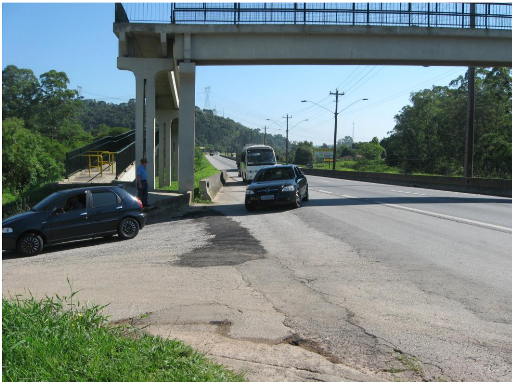
Vista da aproximação do acesso atual - passarela
