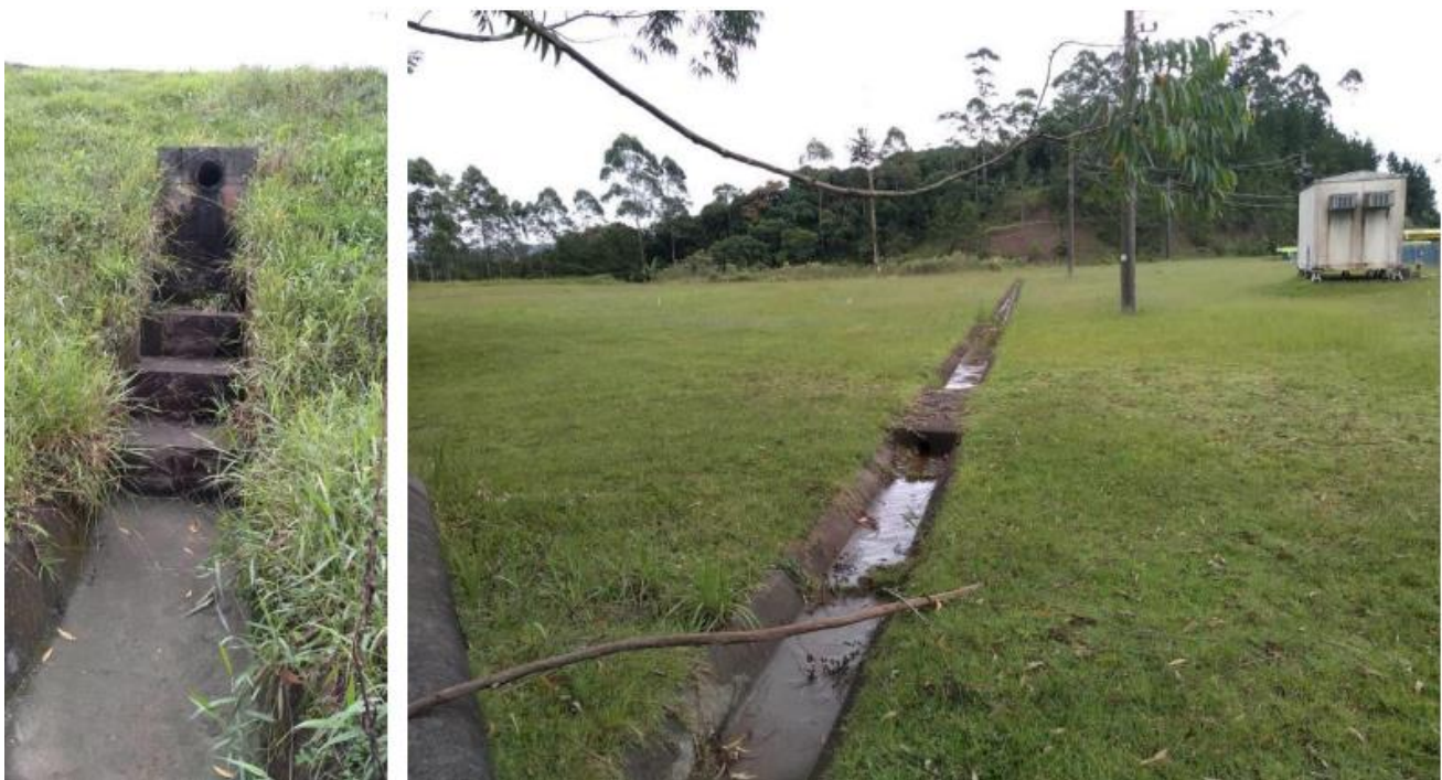
Dispositivos de drenagem existentes na área da ocorrência da ruptura.
