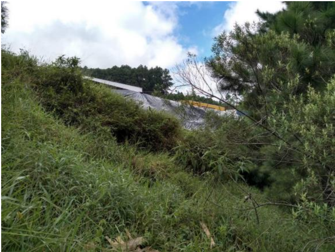
Vista do local da ruptura, protegida por lona plástica, visualizada de ponto mais baixo da topografia local.
