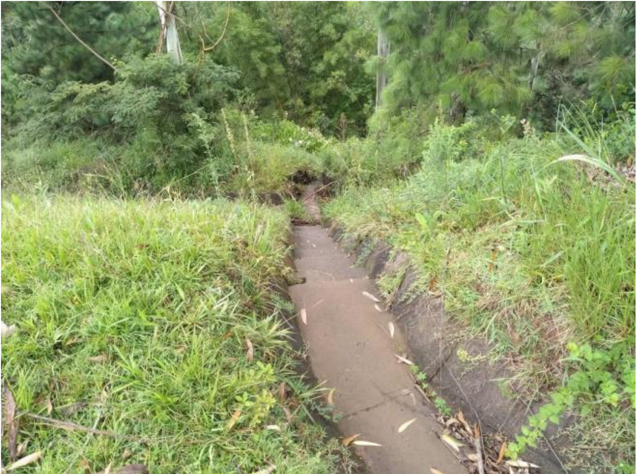
Dispositivo de drenagem existente na área da ocorrência da ruptura.
