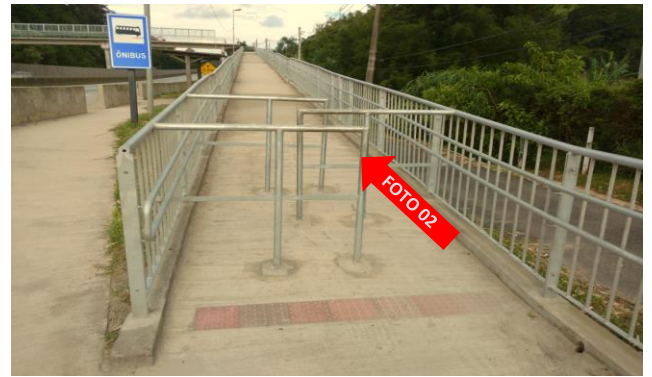
LOCALIZAÇÃO: BLOQUEADOR DE MOTOS RAMPA NORTE
