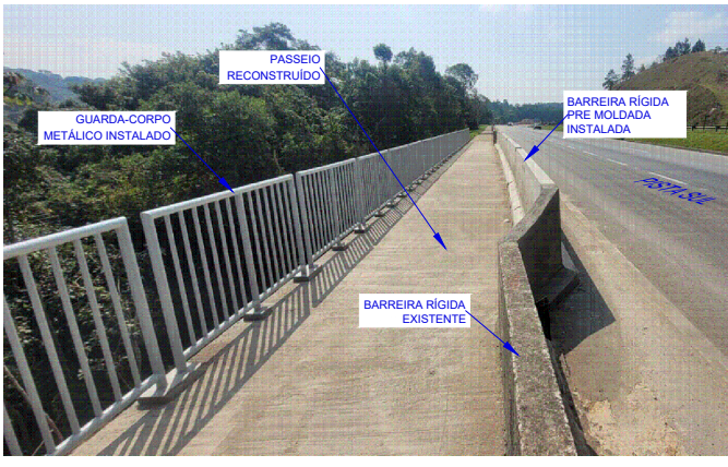
FOTO 01 - SITUAÇÃO CONFORME CONSTRUÍDO
