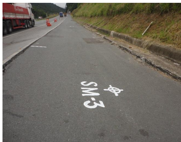
Foto 4: Pé do talude junto à sarjeta de pista.
