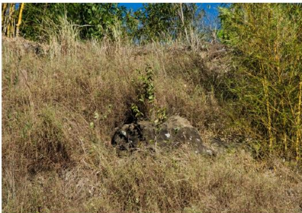
Figura 2.1-6 - Presença de matacão e vegetação na parte superior do talude.
