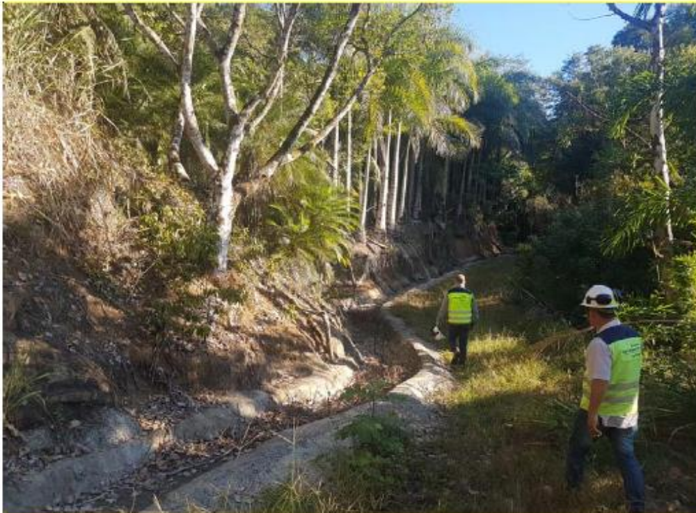
Foto 03 - Detalhe do sistema de drenagem pluvial existente no trecho do talude já tratado. Não será necessário complementar a drenagem deste trecho
