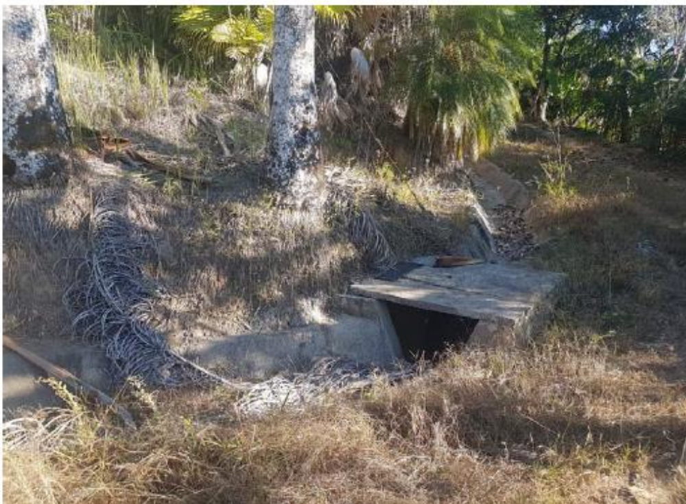
Foto 04 - Detalhe do sistema de drenagem pluvial existente no trecho do talude já tratado. Não será necessário complementar a drenagem deste trecho
