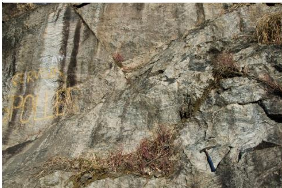
Figura 2.1-4 - Maciço Rochoso pouco alterado, notável presença de descontinuidades
