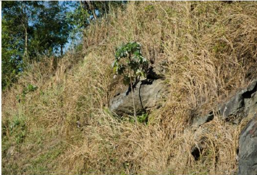
Figura 2.3-4 – Matacão na parte superior do talude.
