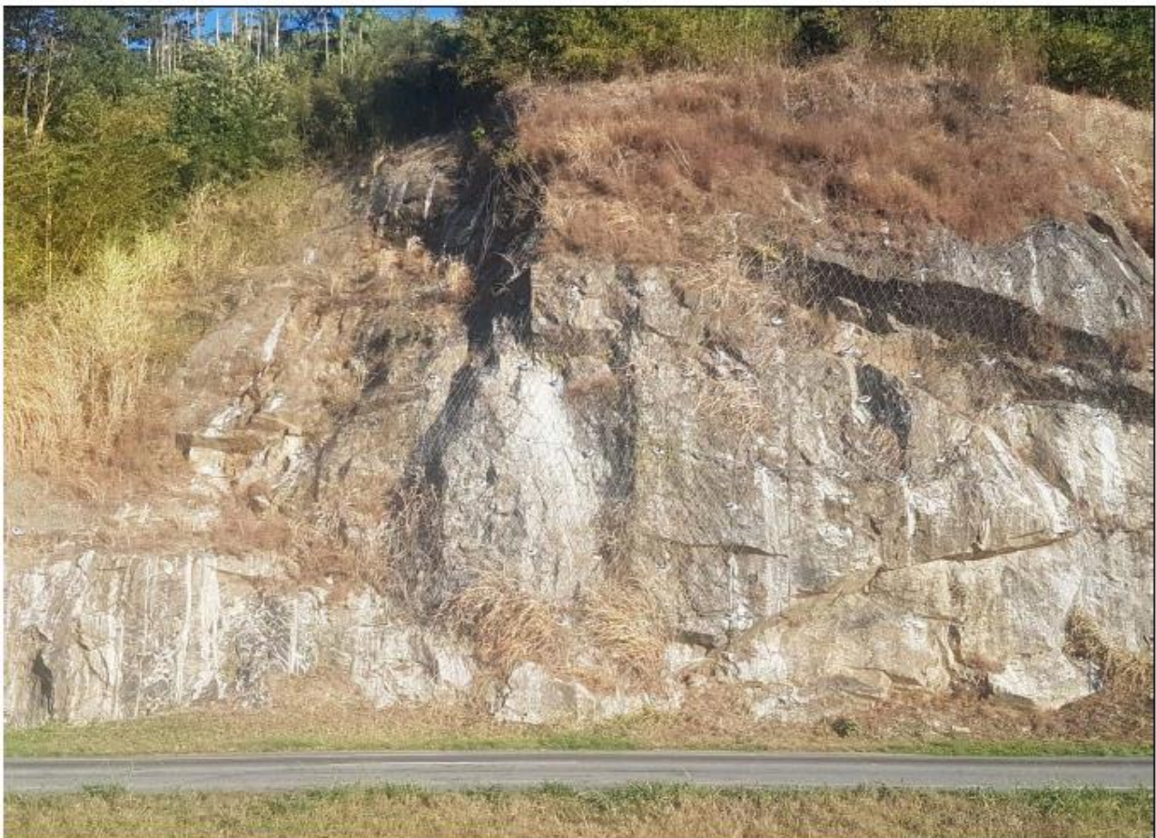
Foto 01- Detalhe da região onde será necessário executar um complemento na proteção do talude, com tela metálica chumbada.
