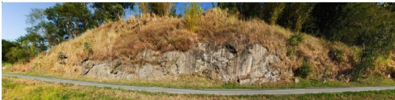
Figura 2.1-1 – Panorama geral do Talude “km 402 + 800 m”.
