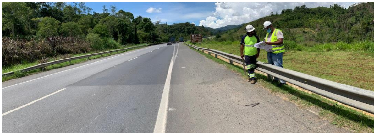
Foto 7: Área abrangida pela intervenção paliativa executada em dezembro de 2019, em registro fotográfico de 03/02/2021
