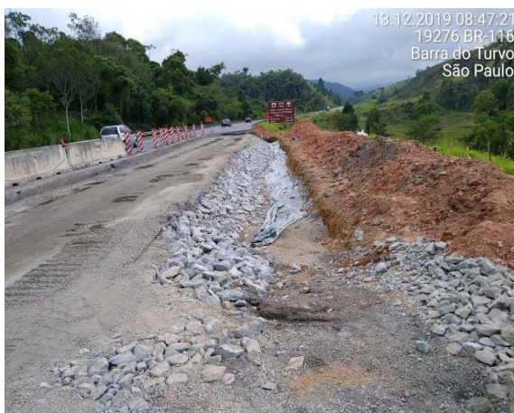
Foto 4: Execução da obra paliativa em dezembro de 2019, para restabelecimento da Faixa 2 e do acostamento.
