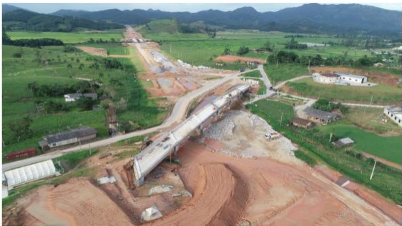
Em fase final de construção: viaduto no trevo com a Estrada Geral Três Riachos
