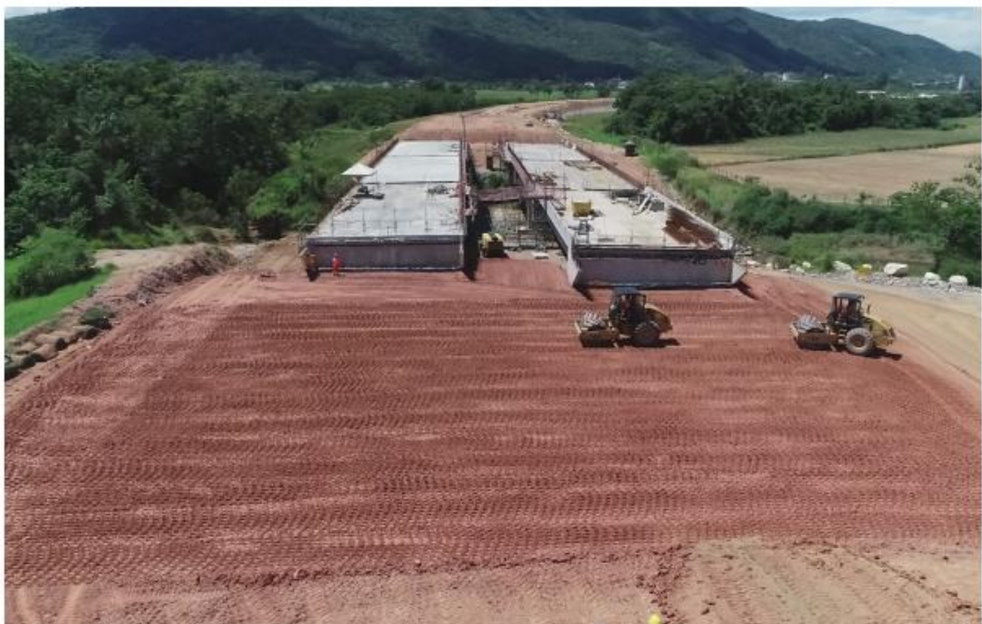
Em fase final de construção: ponte dupla sobre o Rio Biguaçu (km 196)
