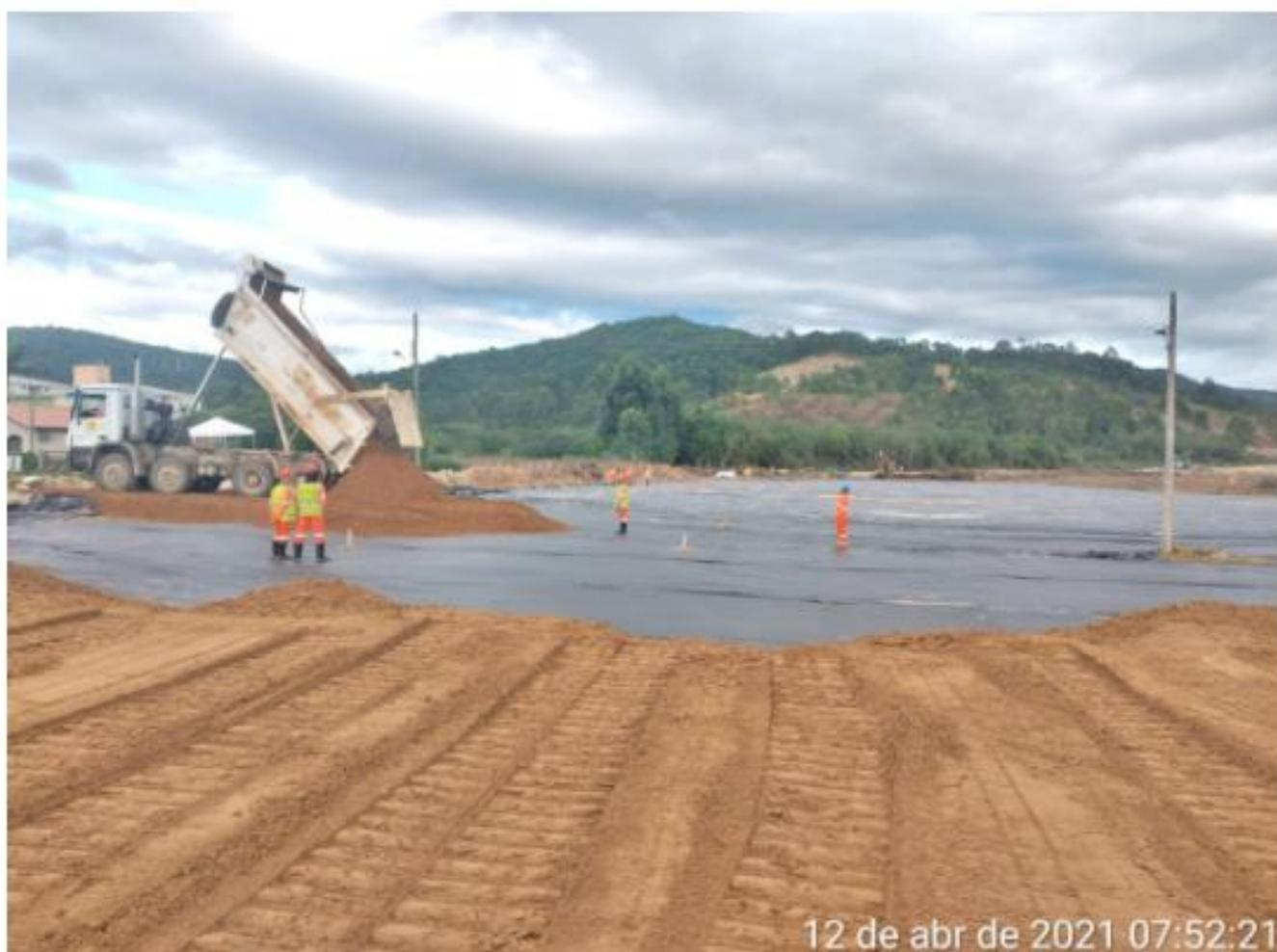
*Aplicação de manta geotêxtil e colchão drenante de areia no solo*
