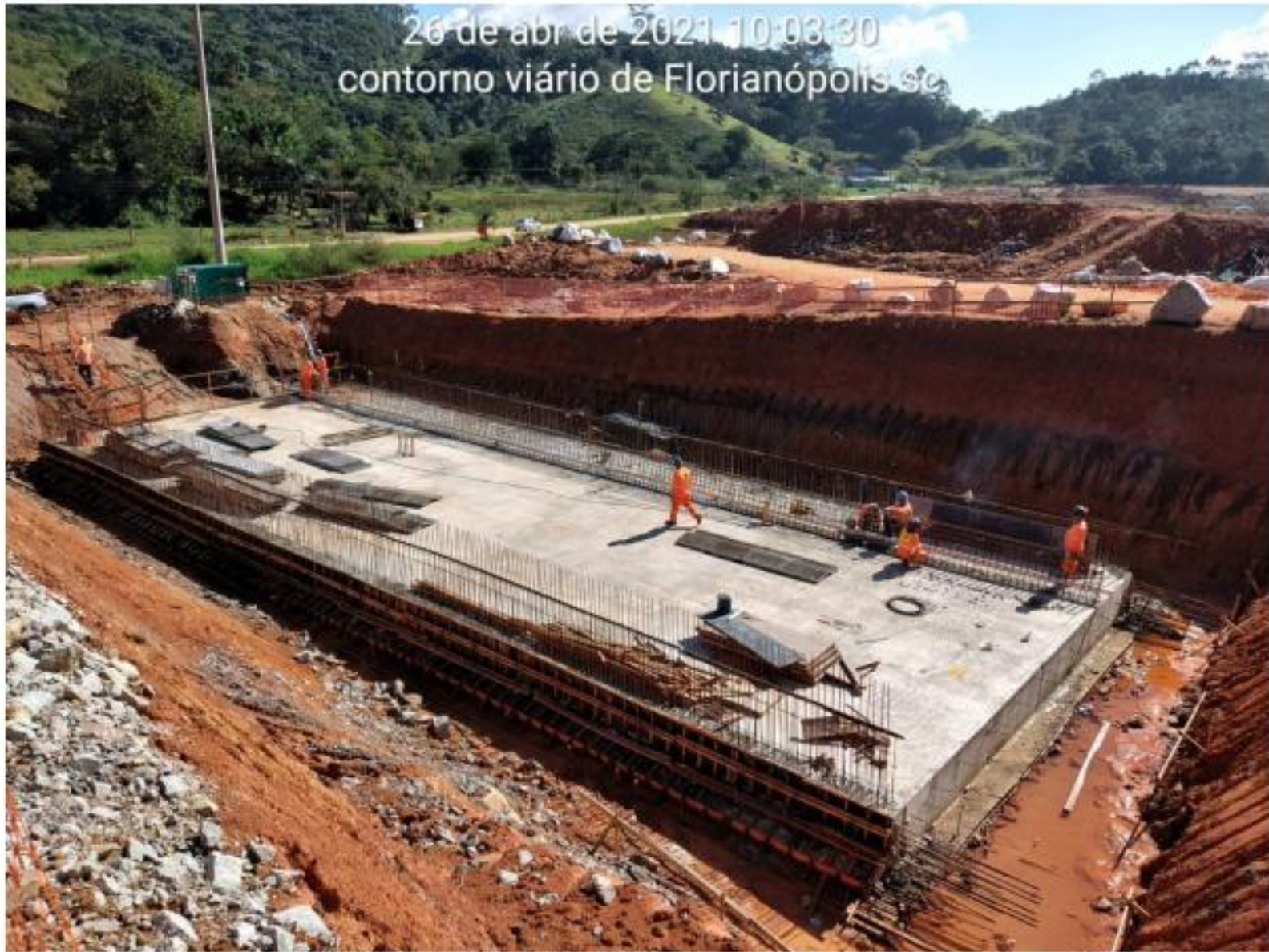
Construção da obra de arte especial da Passagem Inferior do km 184,6
