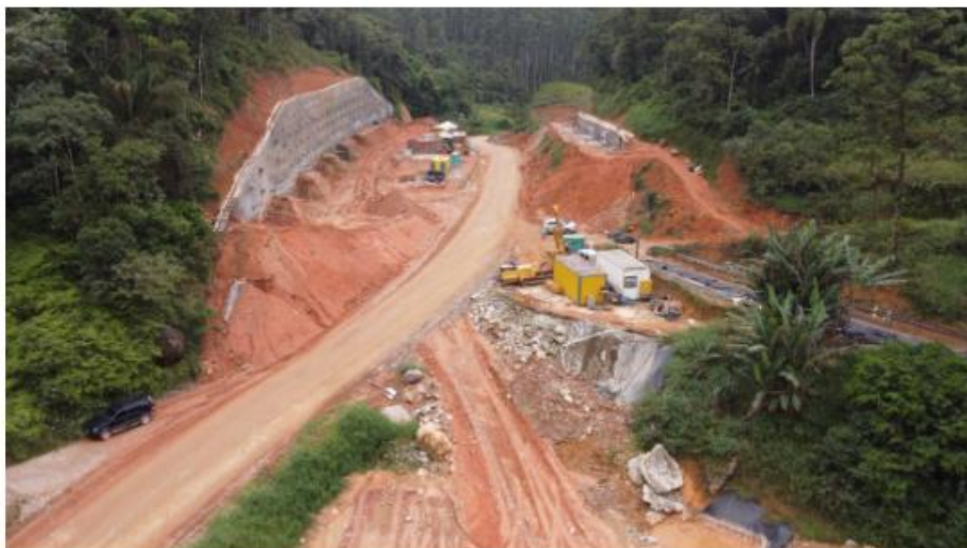
Uso de cortinas atirantadas diminui a necessidade de supressão vegetal
