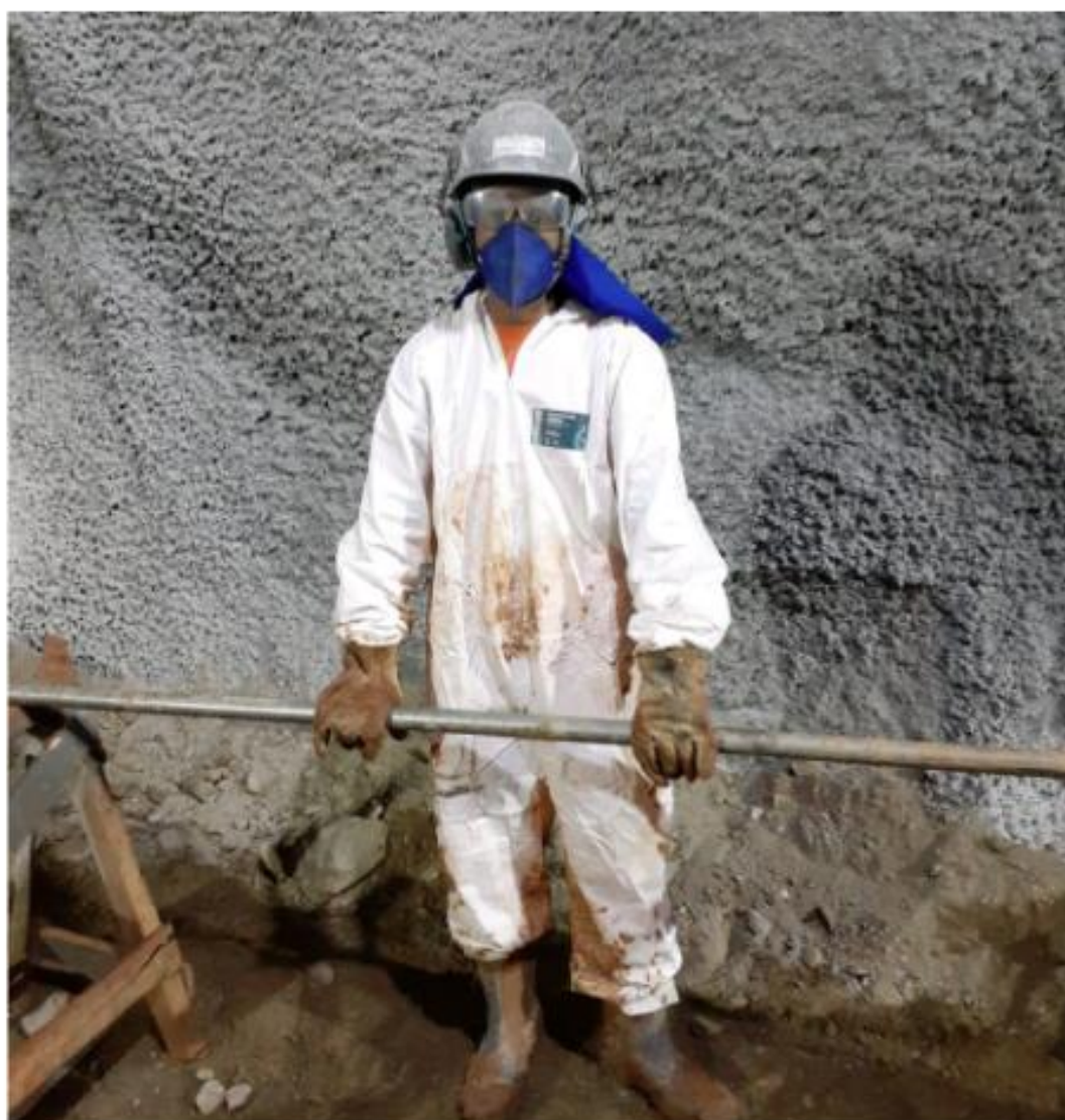
Vindo do Maranhão, Elnatan trabalha no túnel desde o início das obras
