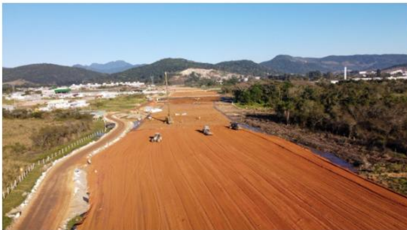
Execução de aterros compactados em solo
