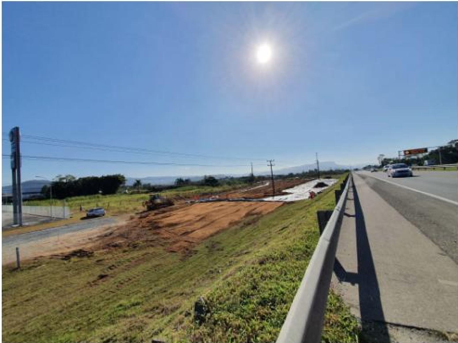
Área do trevo recebe preparação para fundação dos viadutos
