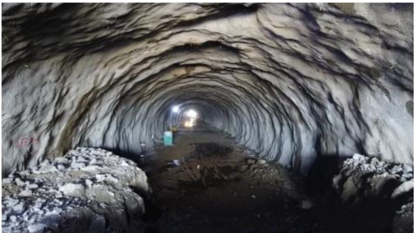
Cada pista do túnel 4 terá 820 metros de extensão
