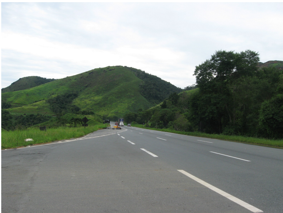
Vista da aproximação do acesso
