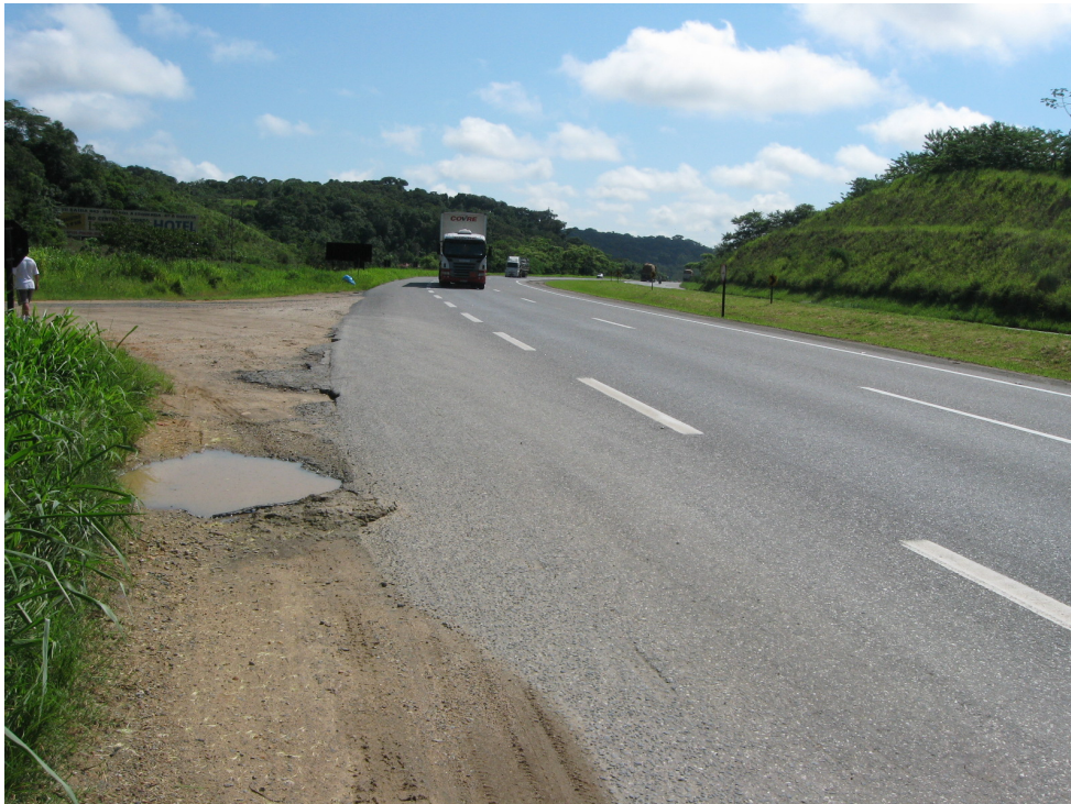
Aproximação do acesso
