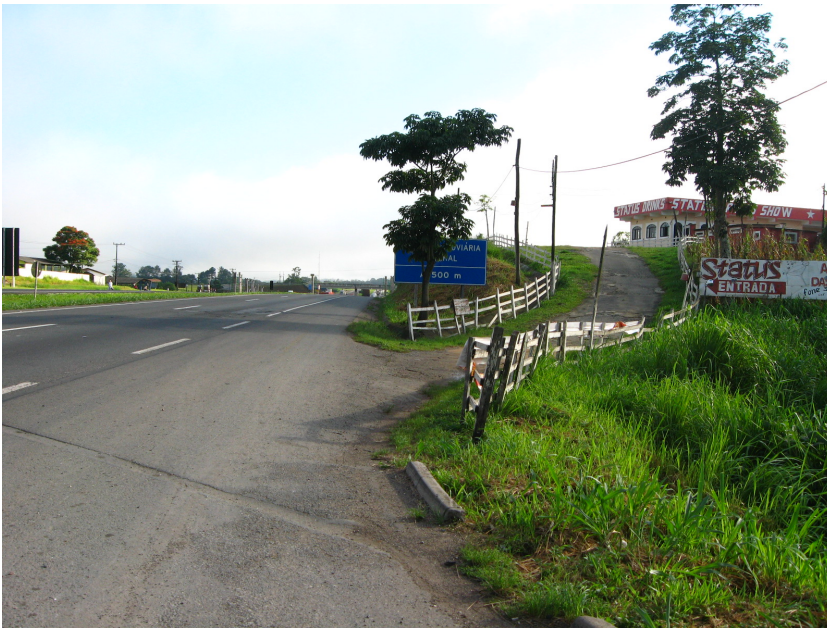
Vista da saída, com acesso particular em seguida
