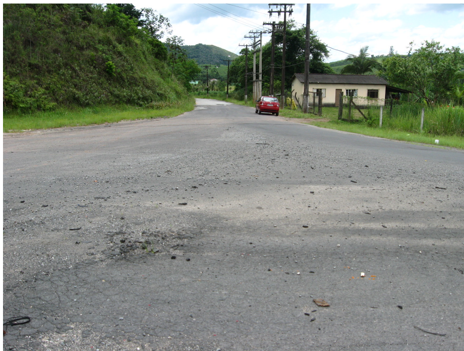
Via de acesso ao bairro Estação vista desde a rodovia
