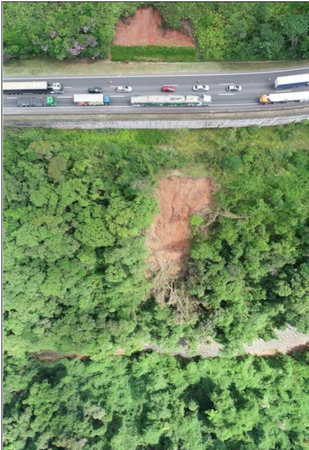
Vista do drone onde é possível observar o rio no pé do talude
