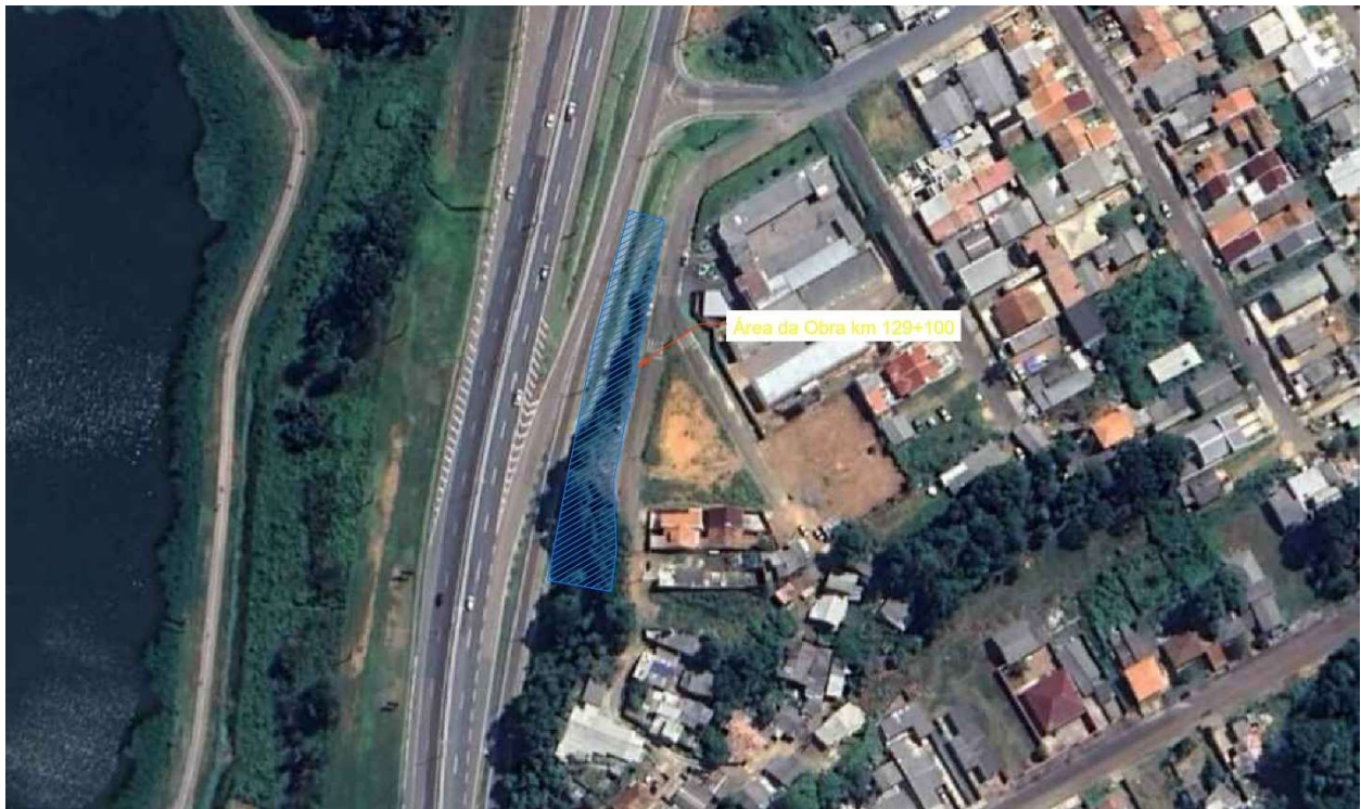
Imagem 1.1.1 – Vista Geral obra km 129+100 PN
