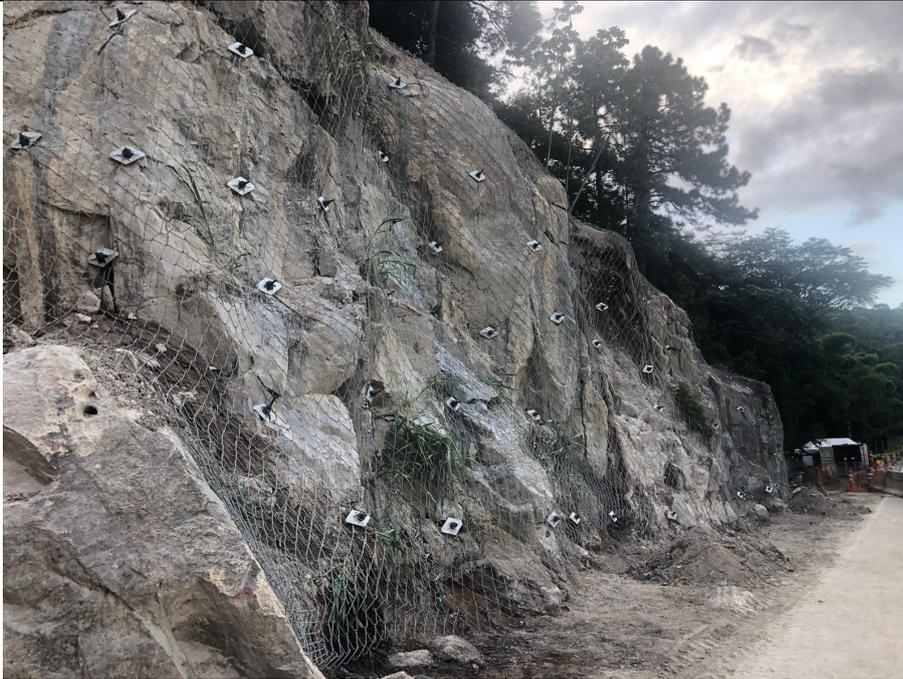
**Figura 17: Instalação de Tela de Alta resistência**
