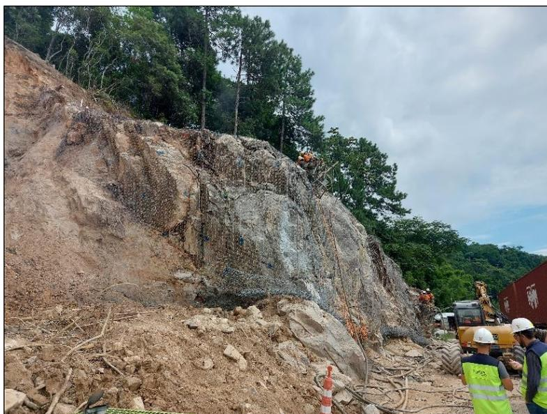
**Figura 1** – Vista da perfuração de chumbadores e instalação da tela Spider sem a tela secundária.
