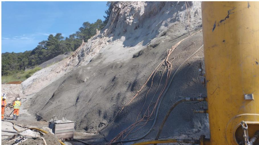
**Figura 20: Projeção de concreto**
