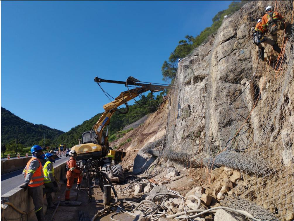
**Figura 02: Perfuração de chumbadores com coluna de perfuração**
