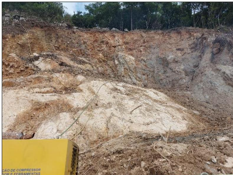
**Figura 2** – Vista da condição da encosta a ser faceada com concreto projetado: na porção inferior, o afloramento de granitoide pouco alterado; na porção superior, a rocha muito alterada, onde os grampos são mais longos; no topo, matacões soltos que deverão ser aprisionados com a tela e grampos ortogonais à superfície do talude.
