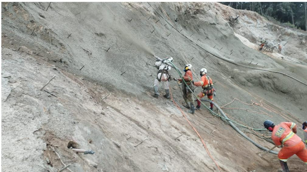
**Figura 06: Projeção de concreto no talude**
