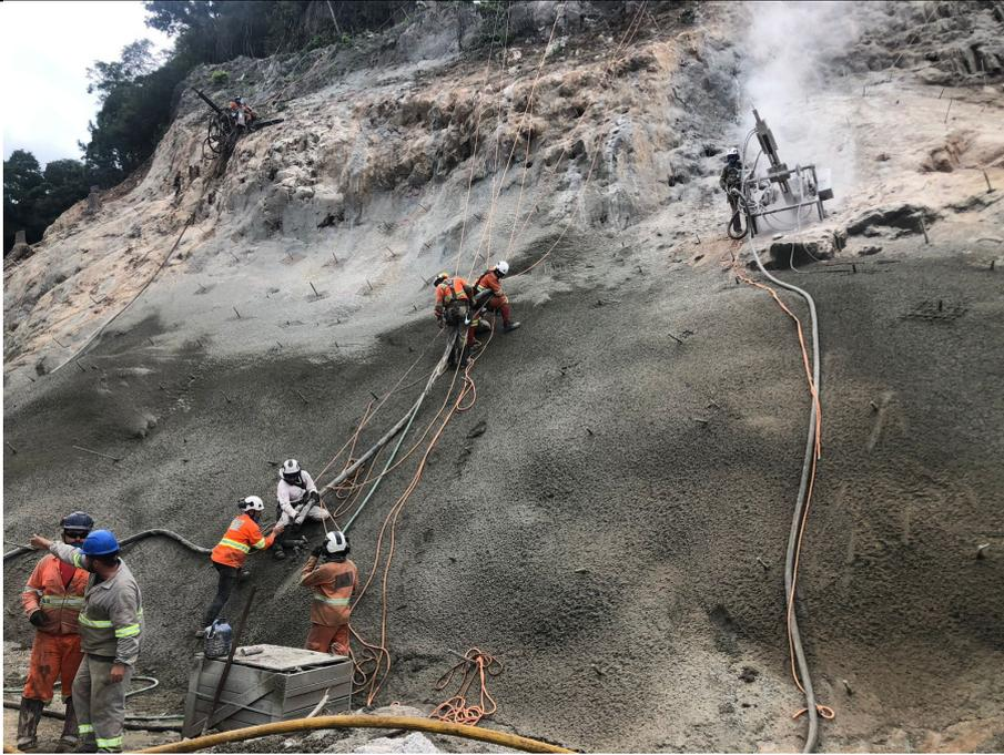
**Figura 19: Projeção de concreto e perfuração**
