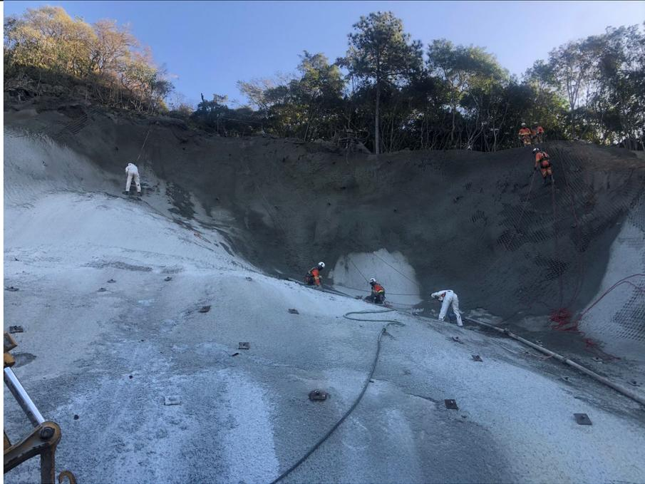
**Figura 21: Projeção de concreto**
