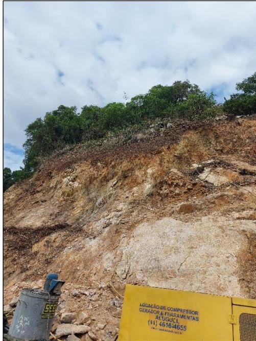
**Figura 3** – Flanco sul próximo à área de contenção existente: vegetação na cista precisa ser limpa em faixa da ordem de 4 metros a partir da crista.
