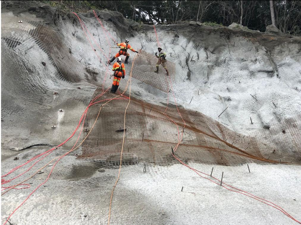
**Figura 07: Instalação de tela eletrosoldada**
