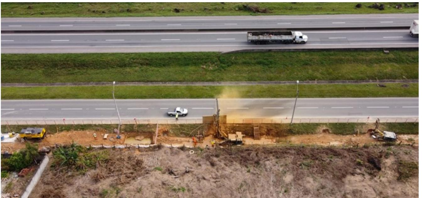
Figura 6: Execução de microestacas
