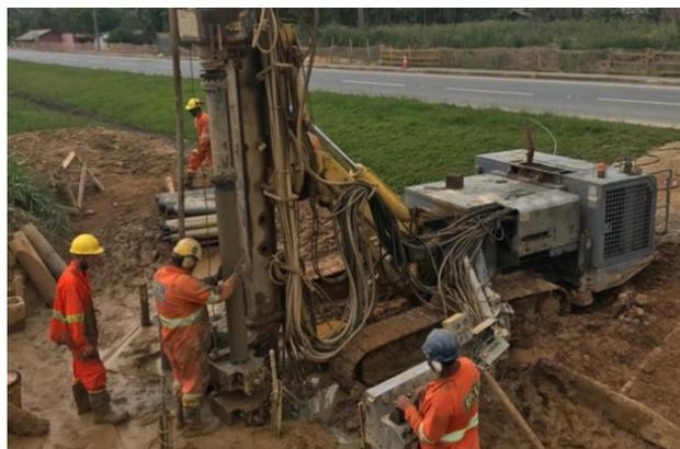
Figura 9: Execução de microestacas – Eixo Central
