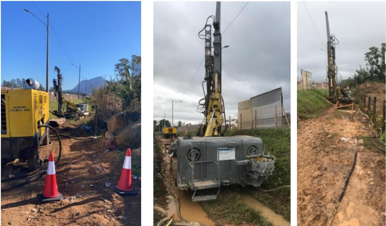
Figura 5: Perfuração microestacas
