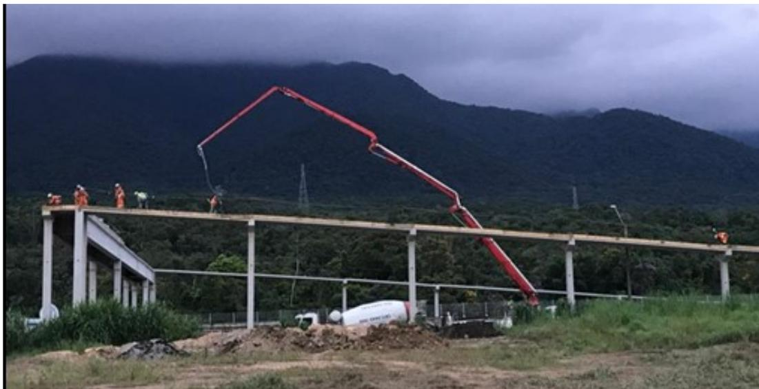
Figura 23: Concretagem da laje Alveolar da passarela
