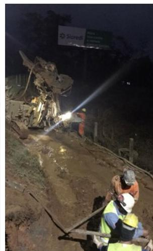
Figura 8: Execução de microestacas
