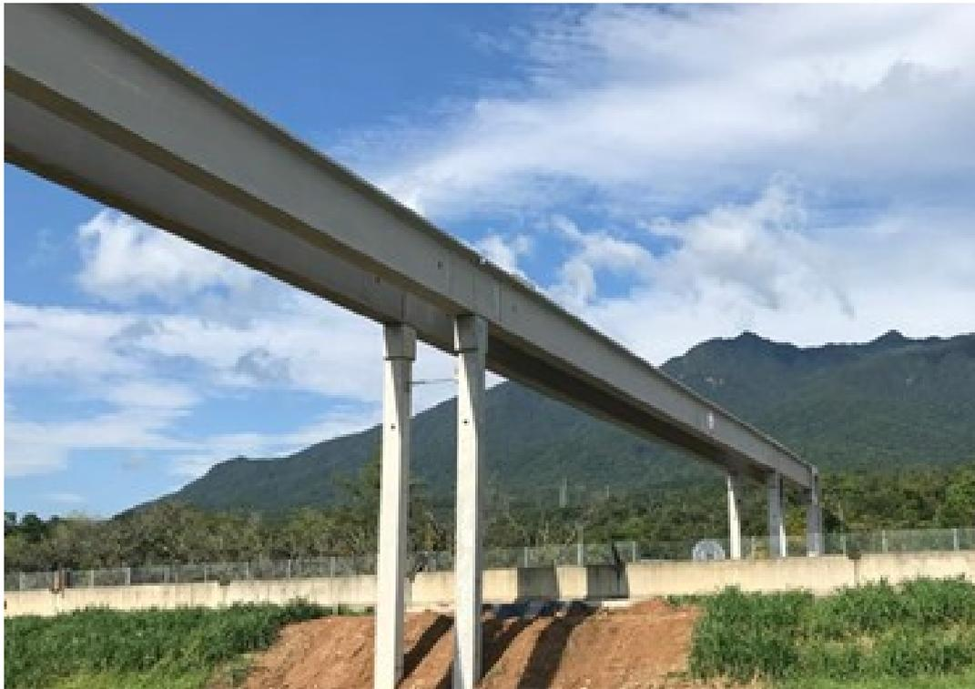
Figura 20: Vigas Travessia Passarela
