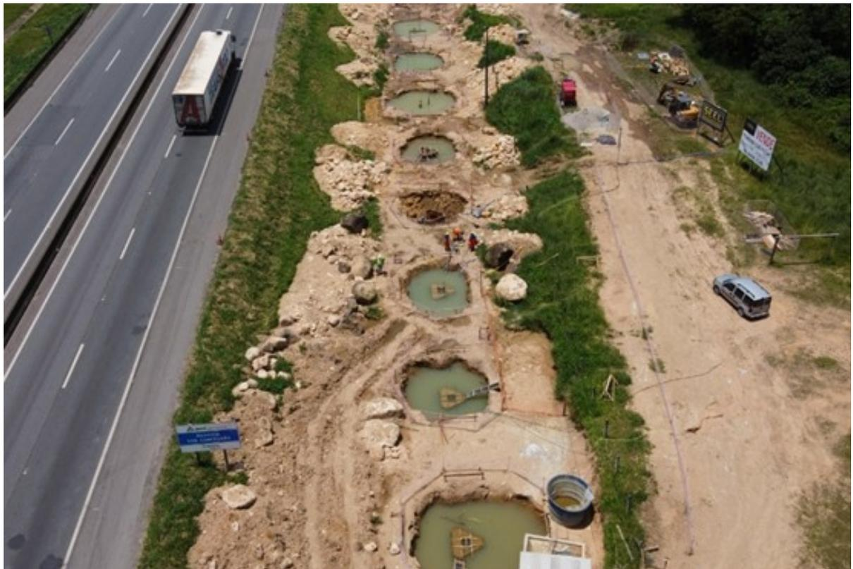
Figura 17: Blocos – Fundação Pista Sul
