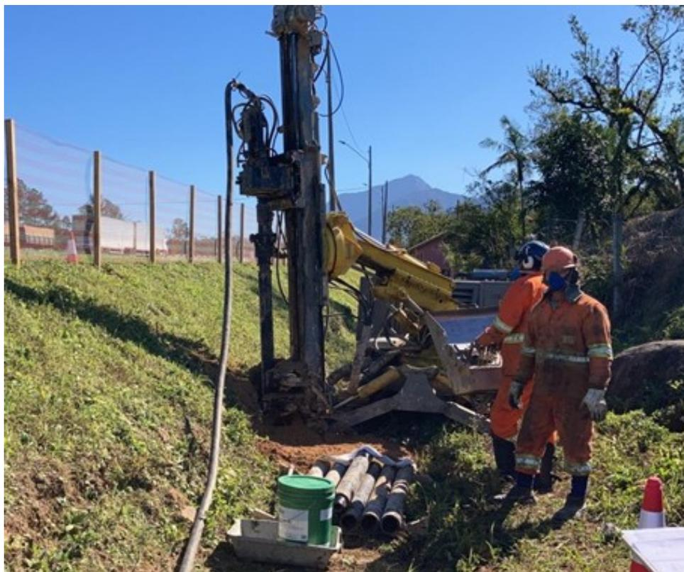
Figura 4: Perfuração microestacas – Pista Norte
