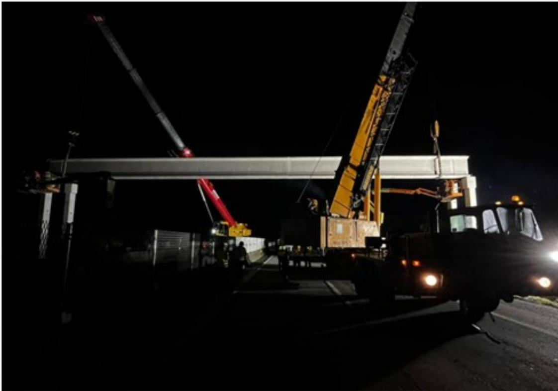
Figura 18: Instalação Vigas Travessia Passarela
