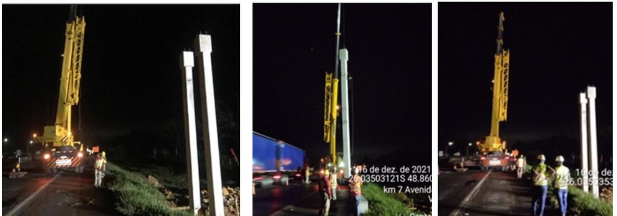
Figura 15: Içamento/instalação dos pilares – Pista Sul/Norte
