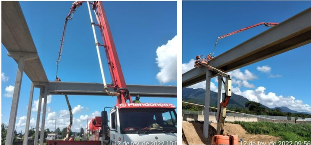
Figura 22: Concretagem da laje Alveolar da passarela
