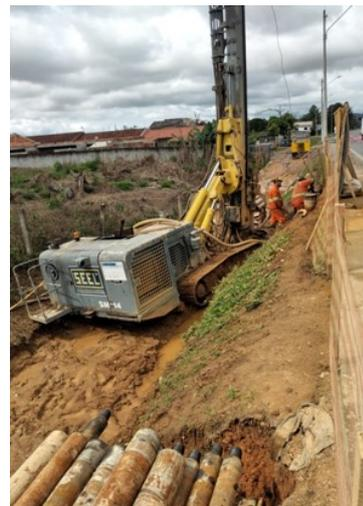
Figura 7: Execução de microestacas
