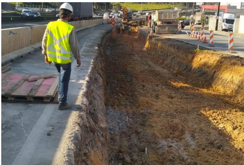
Figura 106 – Finalização da escavação.
