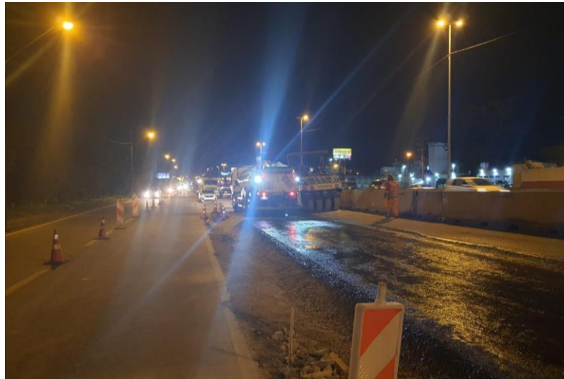
Figura 24 – Aplicação da imprimadura impermeabilizante.
