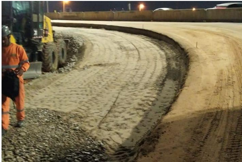
Figura 68 – Compactação de sub-sabe.
