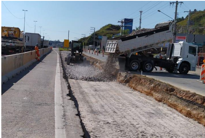
Figura 116 – Aplicação de macadame.
