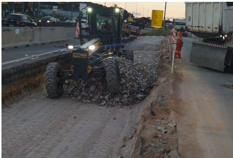
Figura 115 – Aplicação de macadame.
