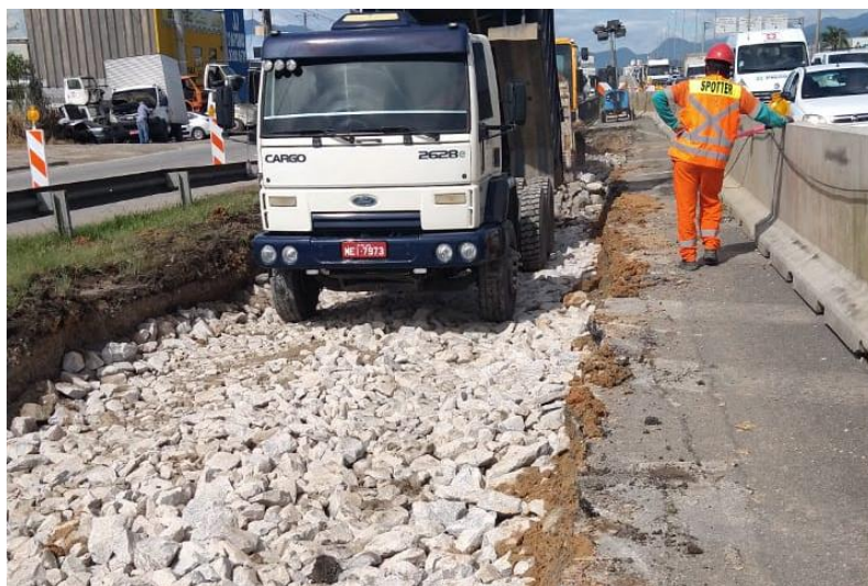
Figura 140 – Execução de sub-base.
