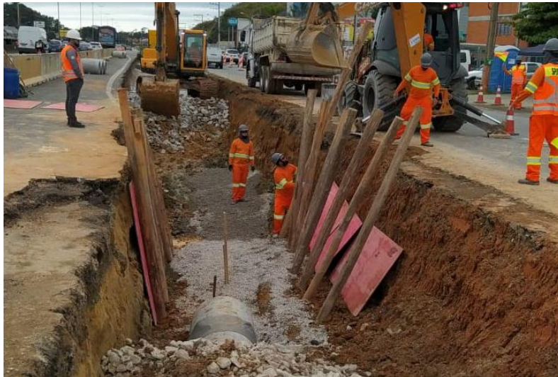
Figura 114 – Execução da agulha.
