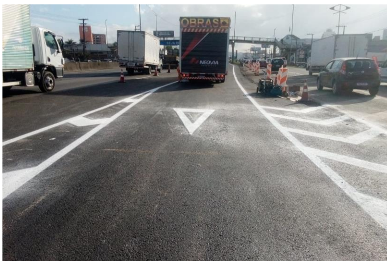
Figura 165 – Pintura sinalização horizontal.
