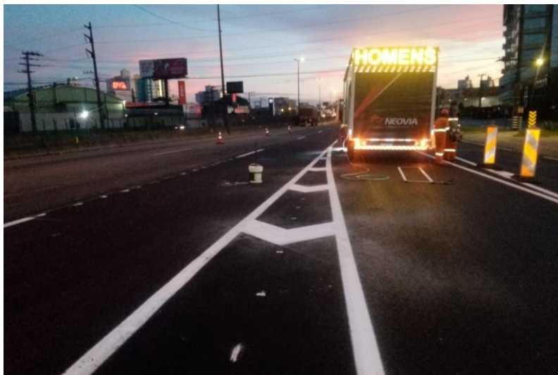
Figura 61 – Pintura sinalização horizontal.
