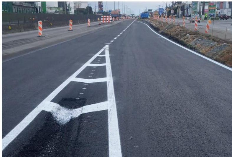
Figura 136 – Pintura sinalização horizontal.
