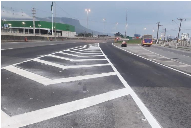
Figura 181 – Pintura sinalização horizontal.
