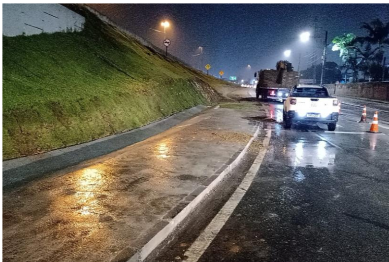
Figura 222 – Execução de passeio.
