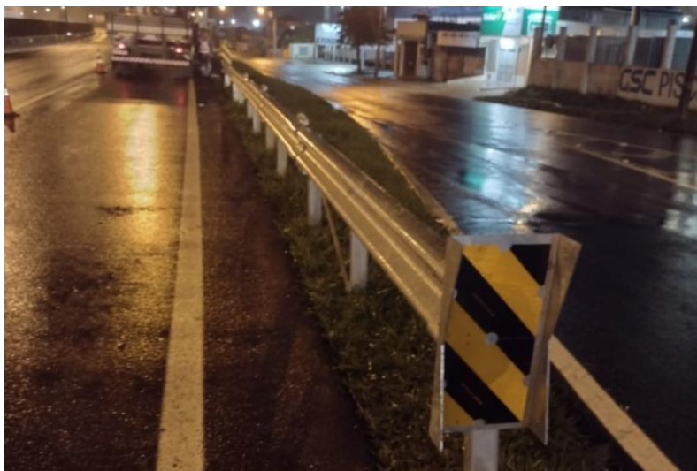
Figura 20 – Absorvedor de energia.
