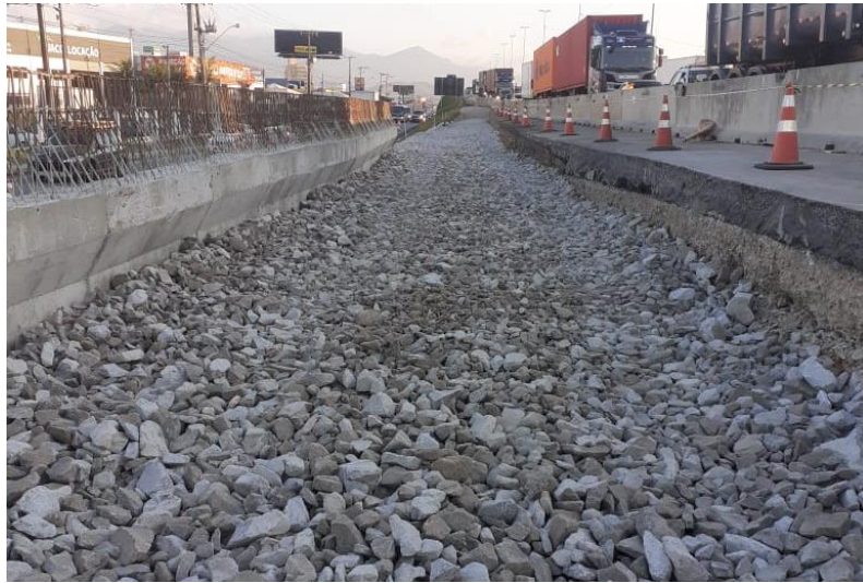
Figura 156 – Execução da sub-base.
