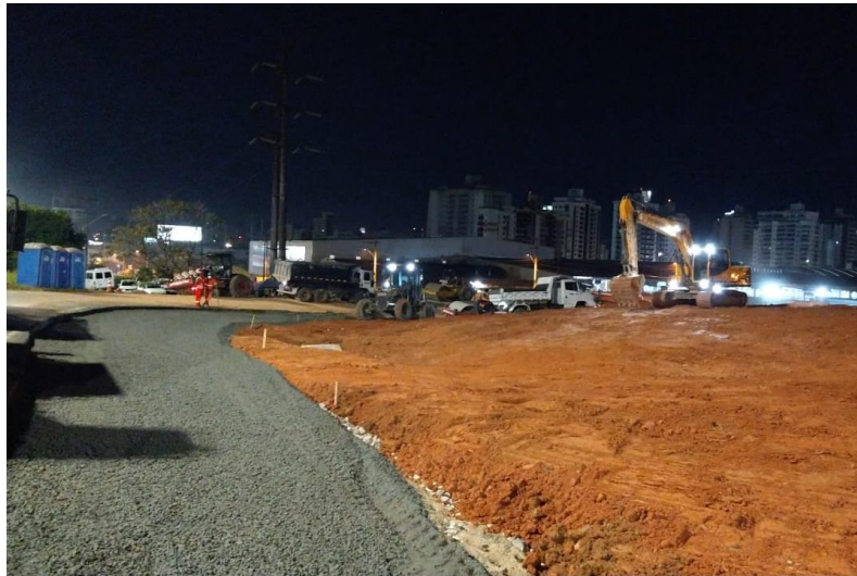
Figura 70 – Aplicação de BGS.
