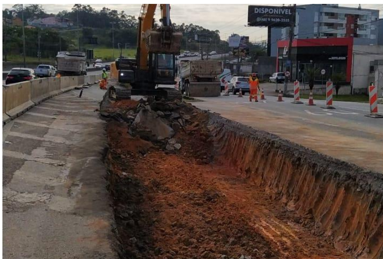
Figura 96 – Escavação da agulha.
