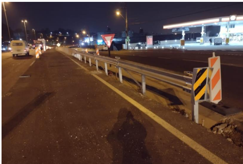
Figura 111 – Absorvedor de energia.
