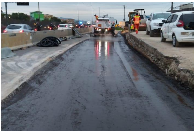
Figura 48 – Aplicação de imprimadura.
