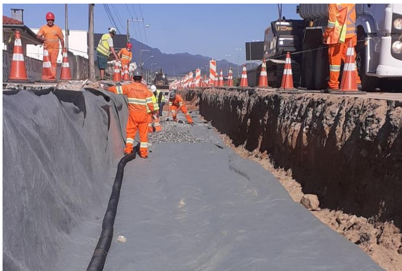
Figura 210 – Execução de dreno de pavimento
