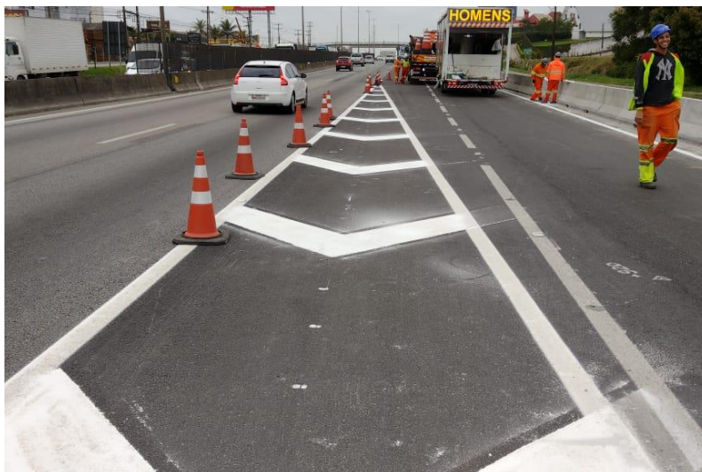
Figura 26 – Sinalização horizontal finalizada.
