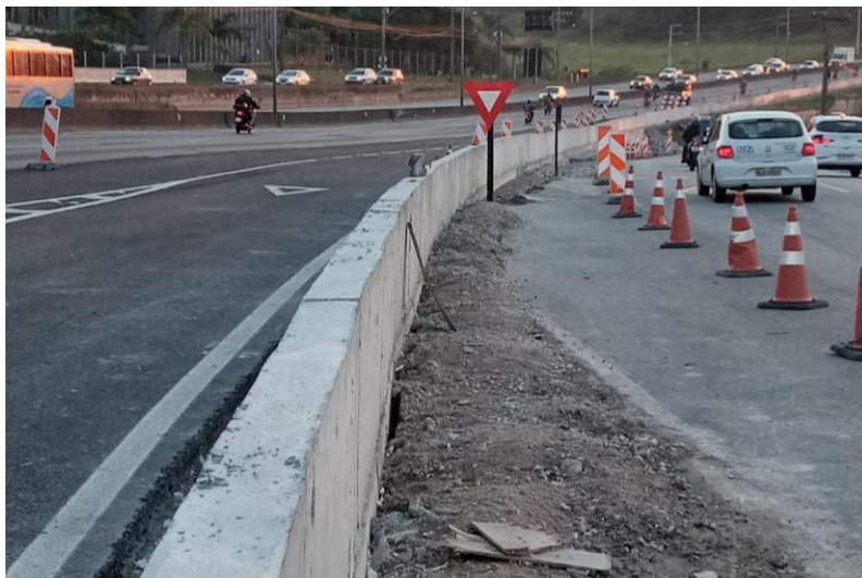
Figura 101 – Barreira de concreto finalizada.
