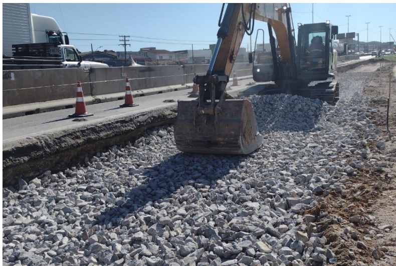
Figura 149 – Execução de sub-base.
