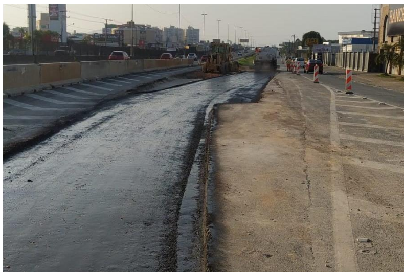
Figura 30 – Aplicação da imprimadura.
