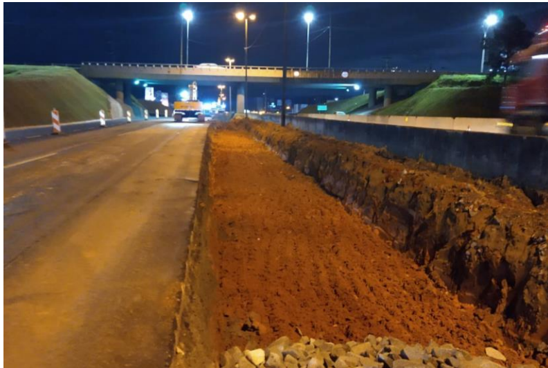
Figura 8 – Terraplanagem faixa 1 – km 205.
