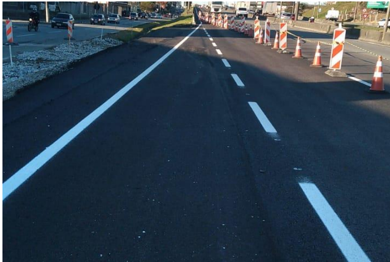
Figura 42 – Pintura sinalização horizontal.
