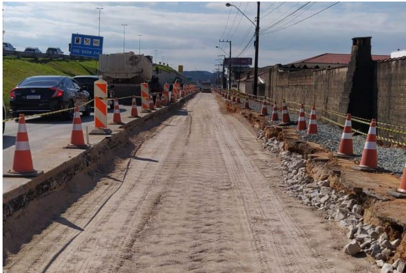
Figura 211 – Execução de sub-base.
