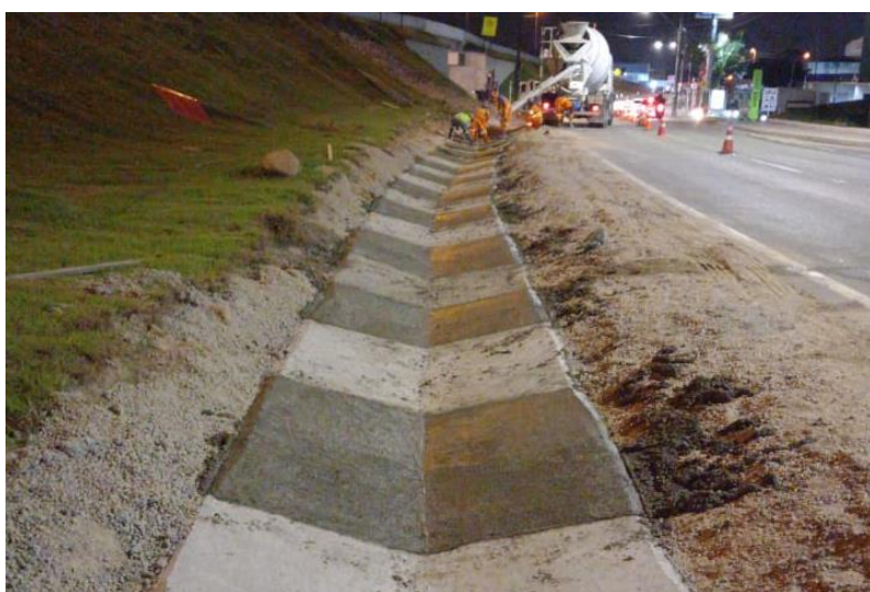
Figura 220 – Concretagem de sarjeta.
