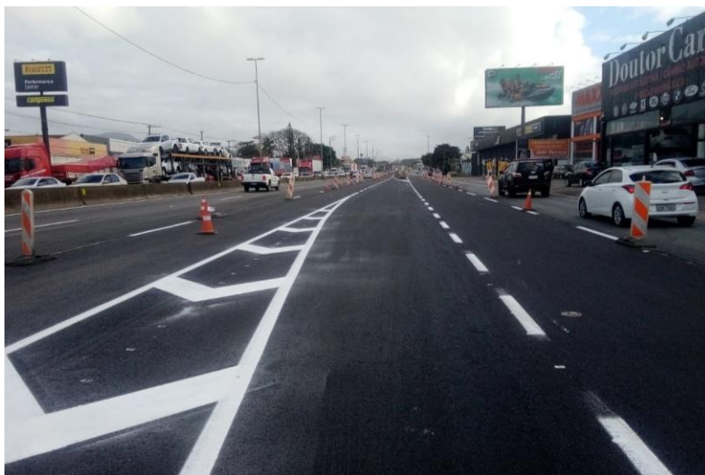
Figura 38 – Pintura sinalização horizontal.
