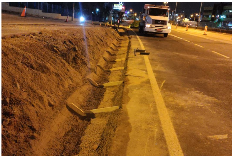
Figura 50 – Execução de sarjeta.
