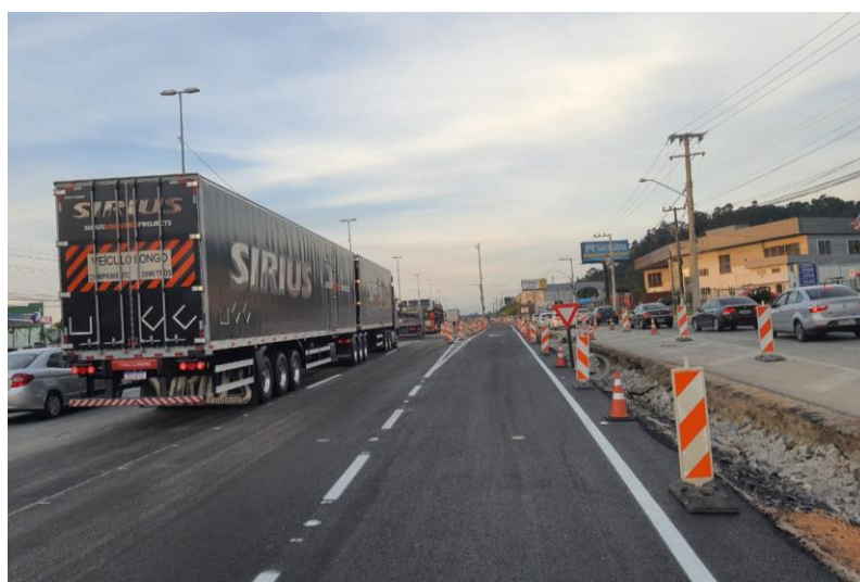
Figura 127 – Sinalização horizontal finalizada.
