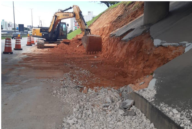
Figura 12 – Serviços preliminares muro grampeado – Ramo 100.
