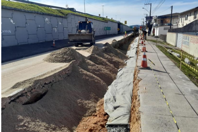
Figura 209 – Execução de dreno de pavimento
