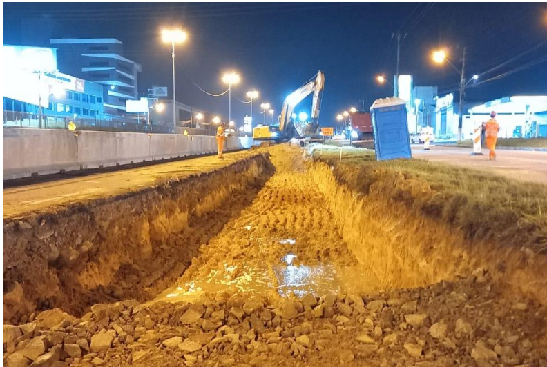
Figura 130 – Escavação da agulha.
