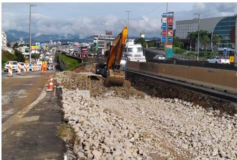
Figura 121 – Execução de sub-base.
