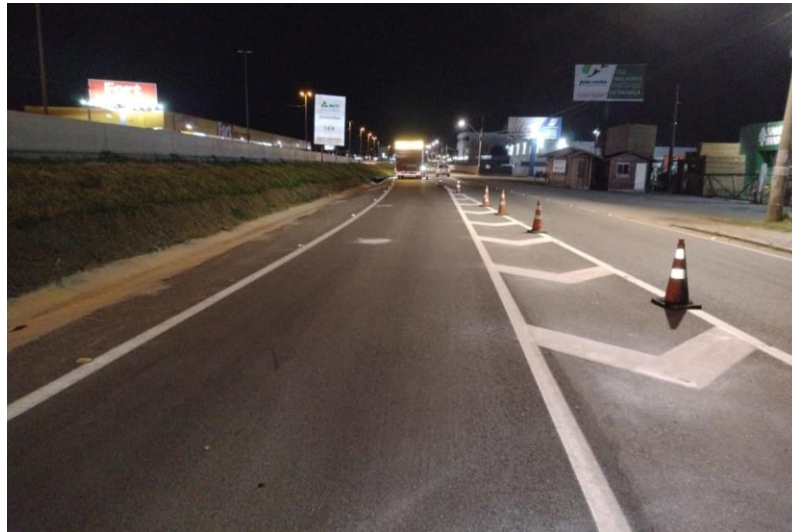
Figura 160 – Pintura sinalização horizontal.
