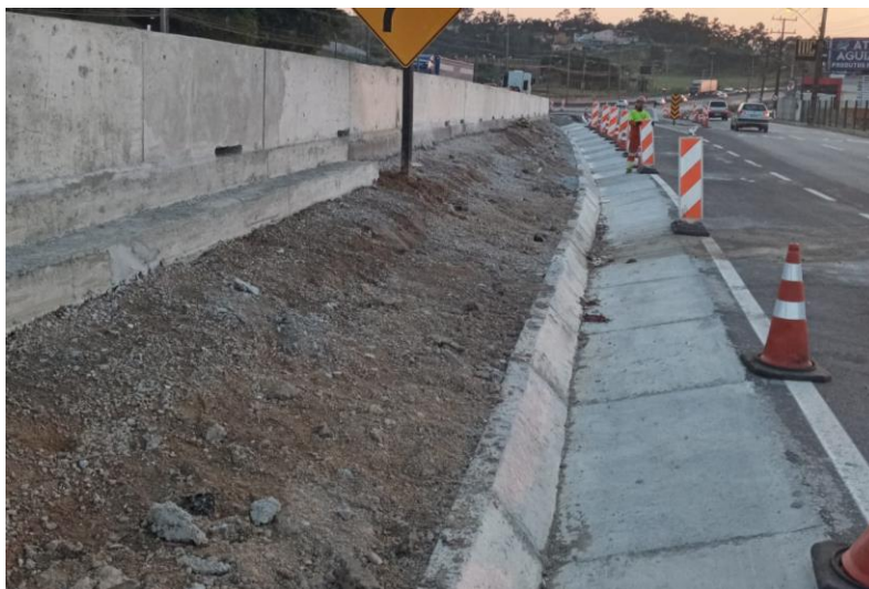
Figura 104 – Sarjeta finalizada.
