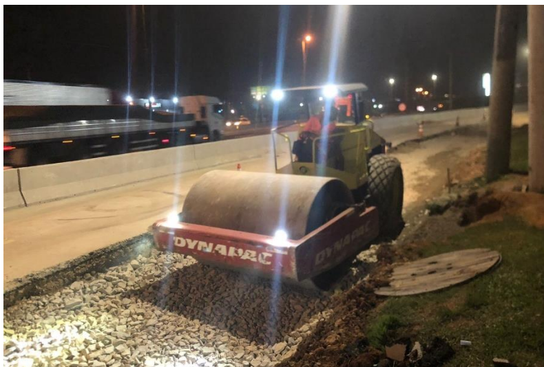
Figura 189 – Compactação de sub-base.
