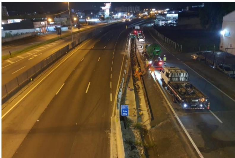
Figura 33– Execução de sarjeta.
