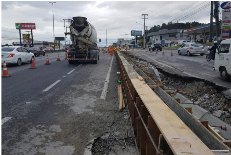
Figura 124 – Concretagem de barreira.
