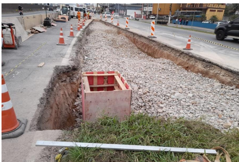
Figura 163 – Execução de caixa coletora.
