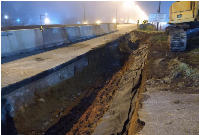
Figura 45 –Execução de dreno de pavimento.
