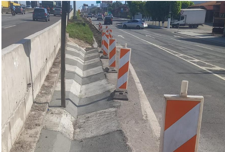
Figura 94 – Execução de sarjeta.
