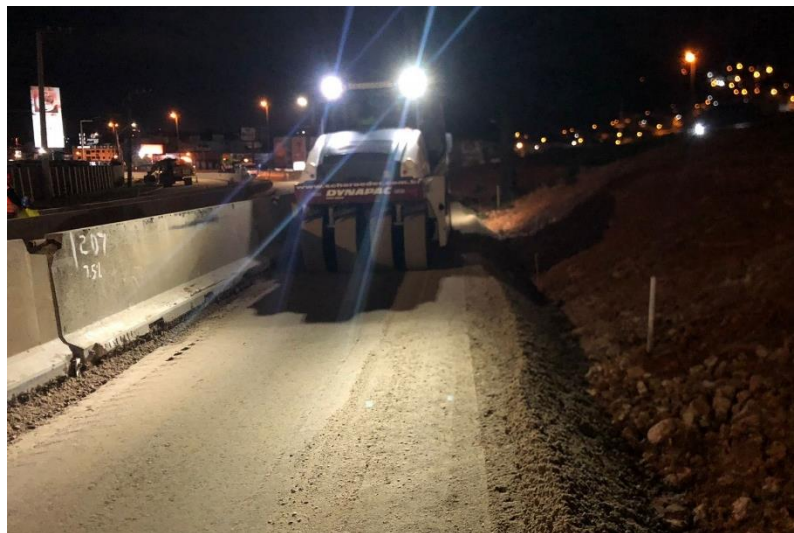
Figura 85 – Compactação de sub-base.
