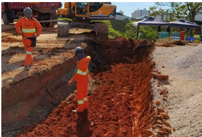
Figura 64 – Escavação da agulha.
