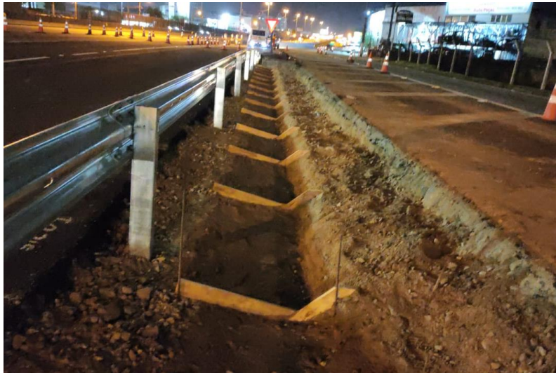
Figura 34 – Preparação de gabarito para sarjeta.
