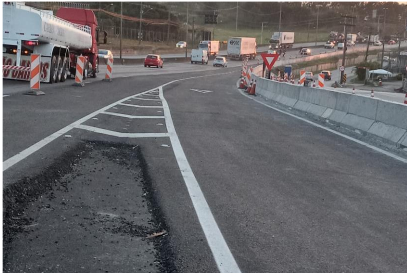
Figura 102 – Sinalização horizontal finalizada.
