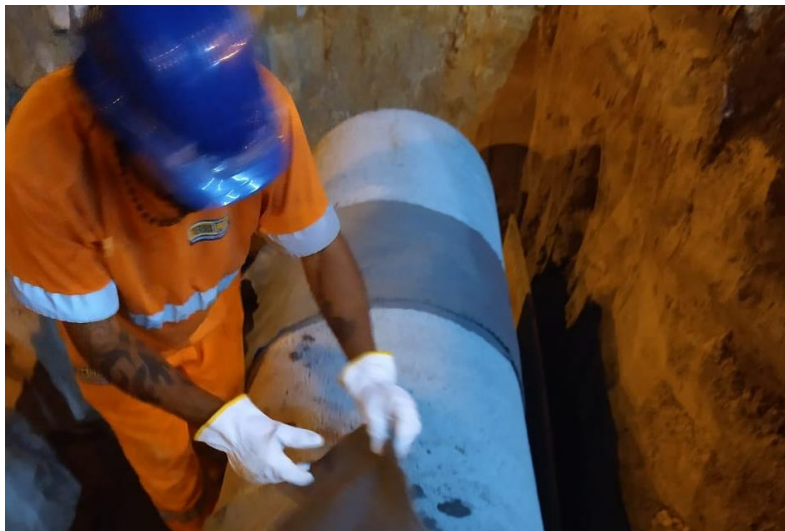
Figura 129– Execução de BSTC Ø 0,60
