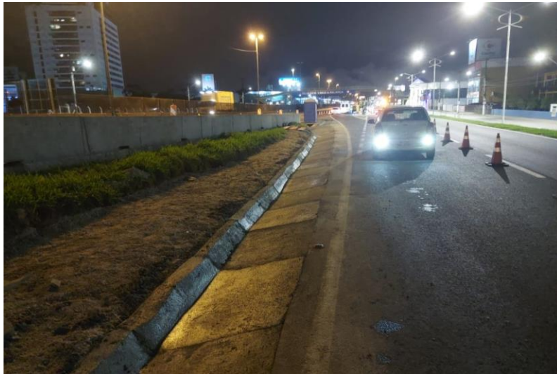
Figura 166 – Execução de sarjeta.
