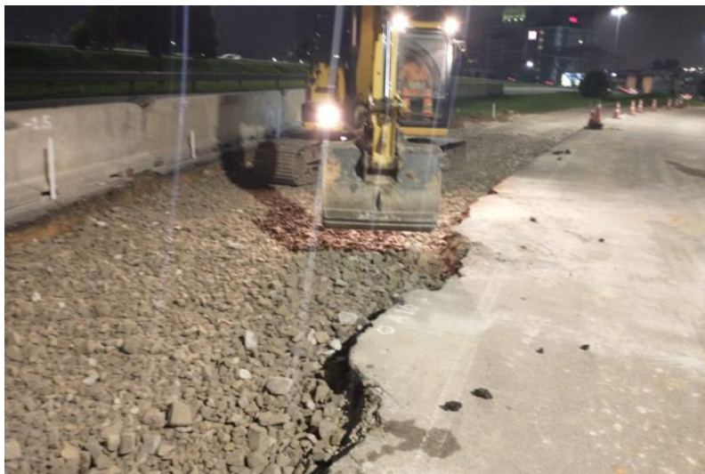
Figura 83 – Compactação de sub-base.
