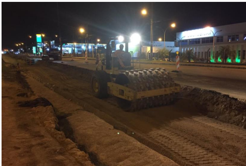
Figura 131 – Execução da sub-base.
