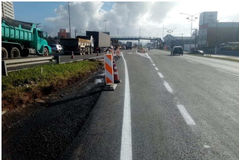
Figura 167 – Pintura sinalização horizontal.
