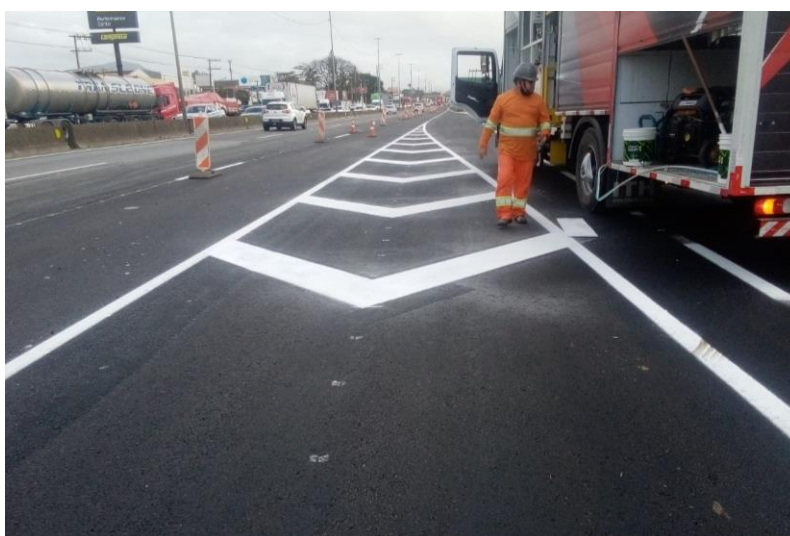
Figura 31 – Sinalização horizontal finalizada.
