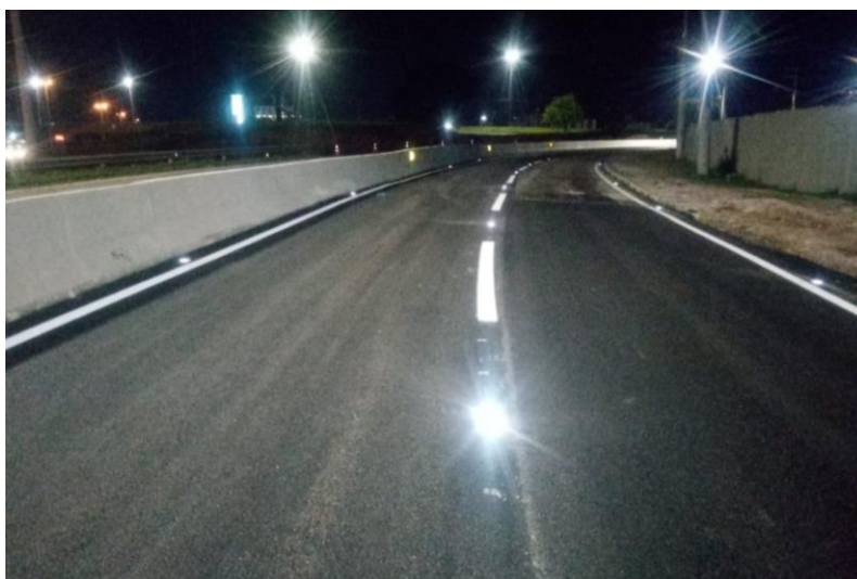
Figura 200 – Pintura sinalização horizontal.
