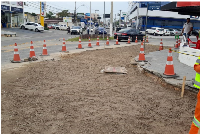
Figura 212 – Execução de sub-base.
