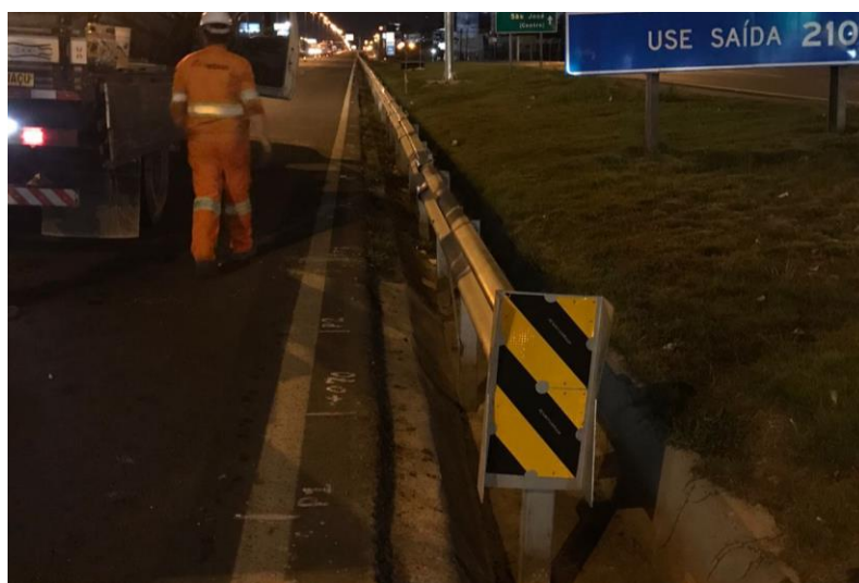
Figura 139 – Absorvedor de energia.
