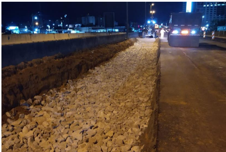
Figura 9– Macadame faixa 1 – km 205.
