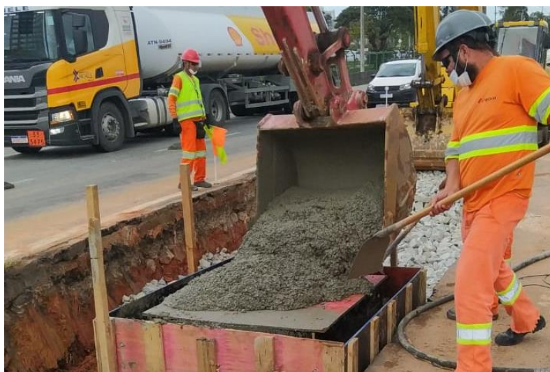
Figura 57 – Concretagem de caixa coletora.
