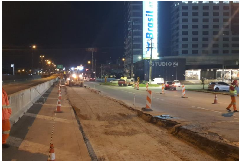
Figura 58 – Sub-base compactada.
