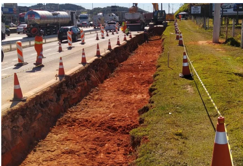
Figura 202 – Escavação da agulha.
