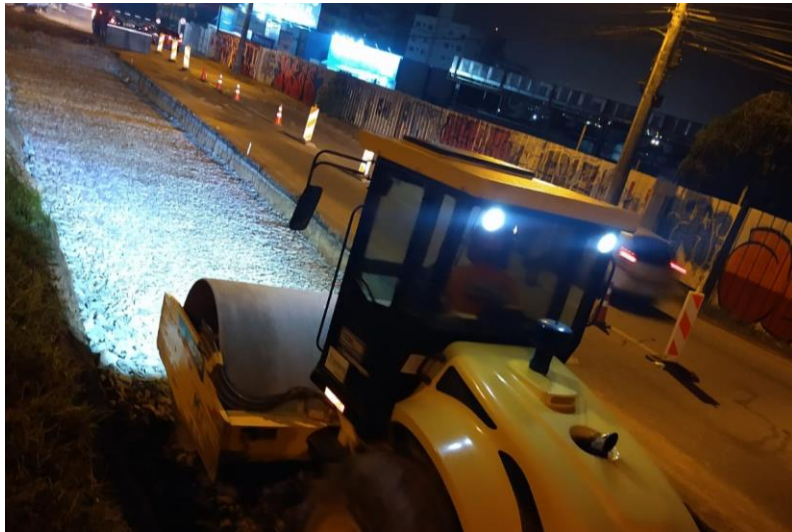
Figura 100 – Compactação de sub-base.
