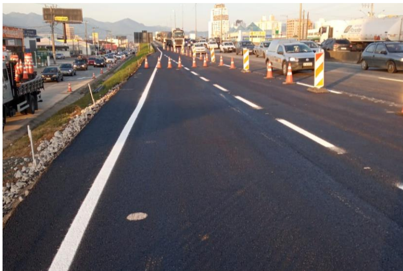
Figura 159 – Pintura sinalização horizontal.
