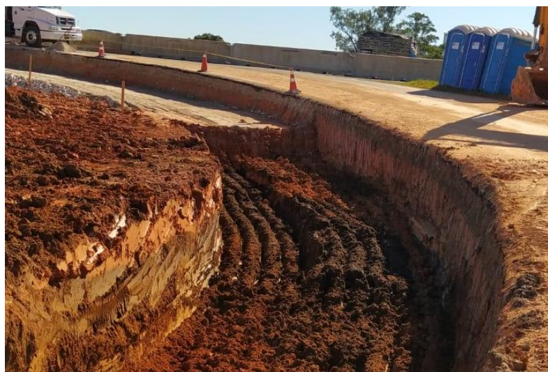
Figura 65 – Escavação da agulha.
