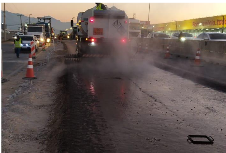
Figura 152 – Aplicação da imprimadura impermeabilizante.
