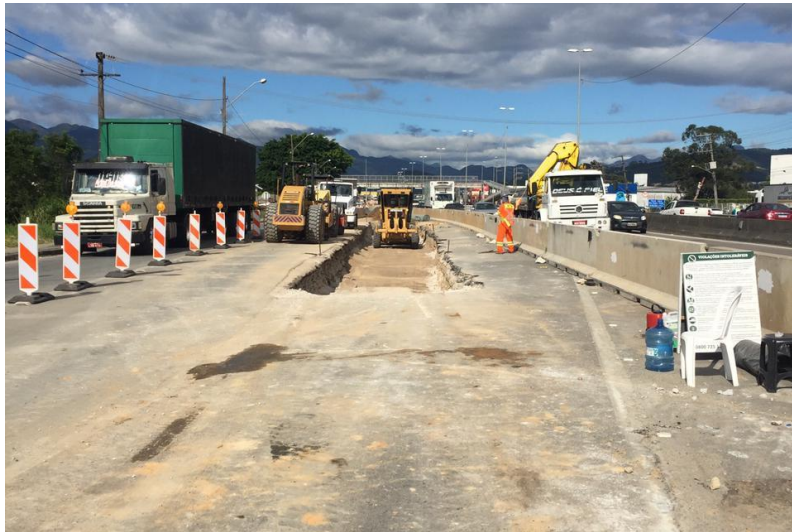
Figura 168 – Escavação da agulha.
