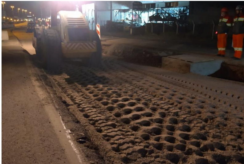
Figura 28 – Camada de travamento.
