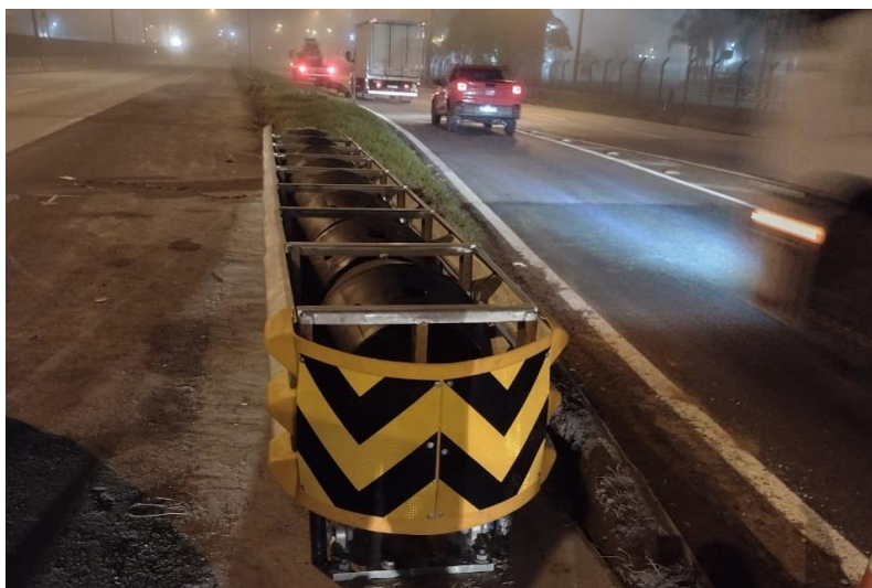
Figura 62 – Atenuador de impacto.
