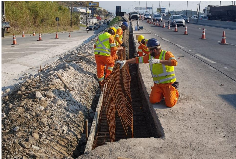
Figura 108 – Preparação da armação para concretagem de barreira.
