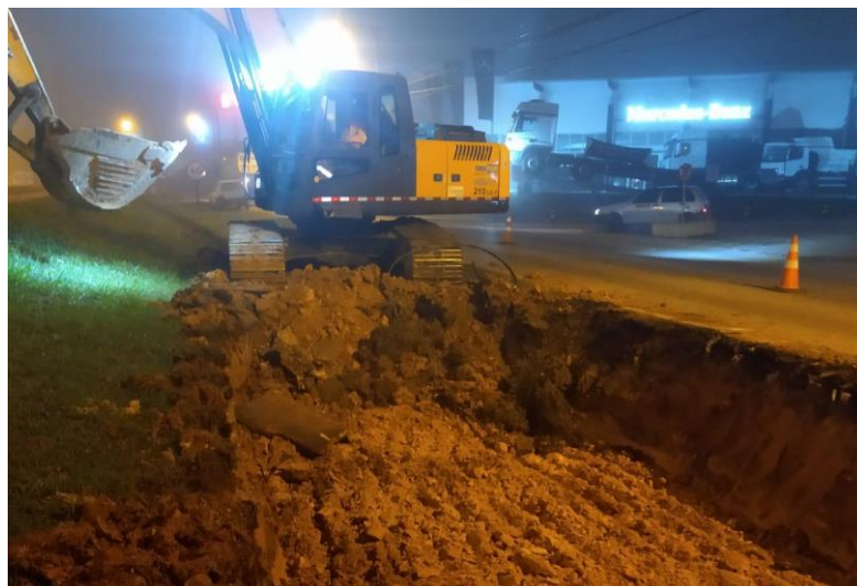
Figura 51 – Escavação da agulha.
