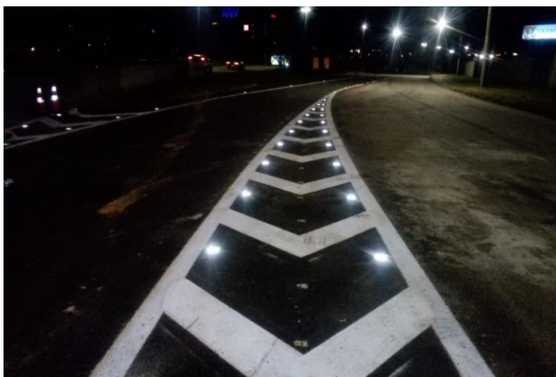
Figura 89 – Pintura sinalização horizontal.
