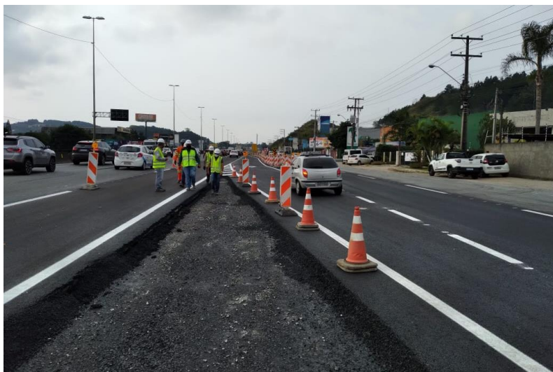
Figura 120 – Pintura sinalização horizontal.
