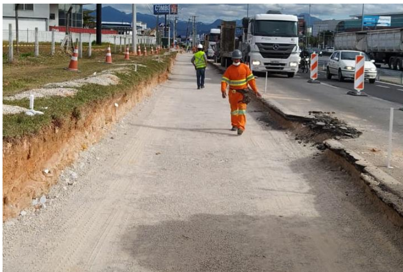
Figura 205 – Execução de sub-base.
