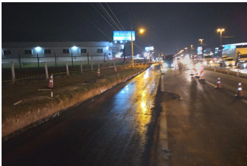
Figura 207 – Aplicação de imprimadura impermeabilizante.
