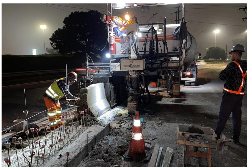
Figura 186 – Execução de barreira extrusada.
