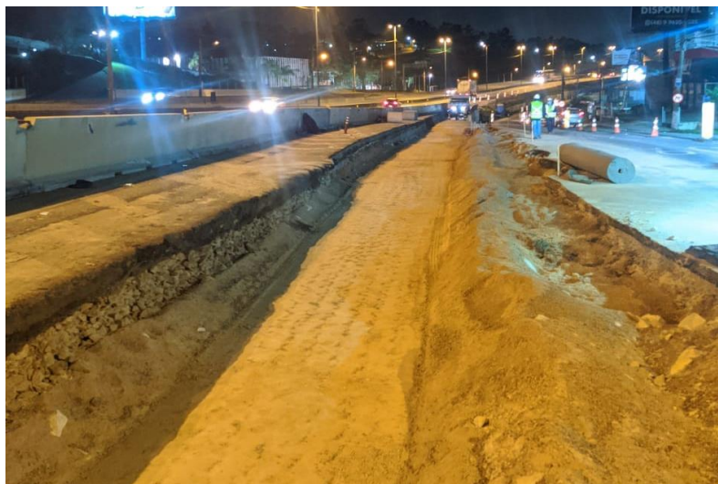
Figura 105 – Compactação de sub-base.
