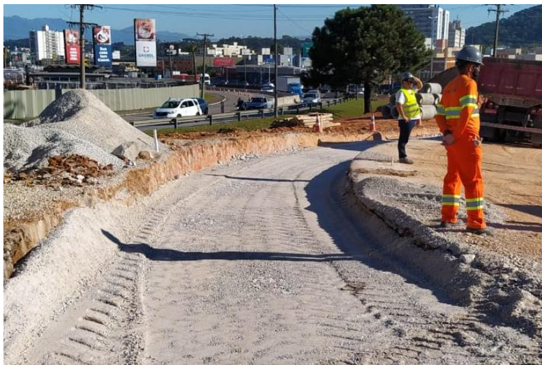
Figura 69 – Compactação de sub-sabe.
