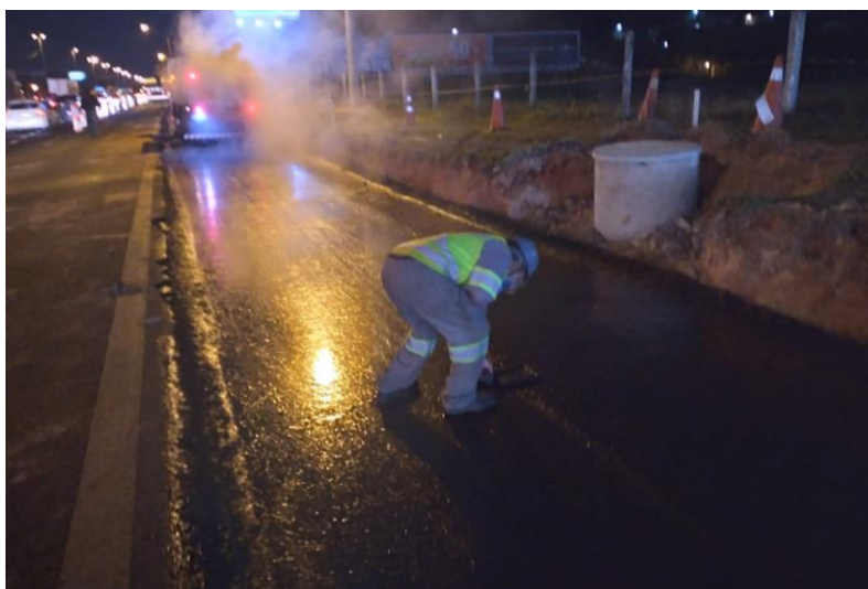
Figura 206 – Aplicação de imprimadura impermeabilizante.
