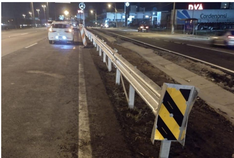
Figura 56 – Absorvedor de energia.
