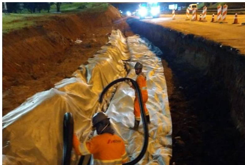
Figura 67 – Execução de dreno de pavimento.
