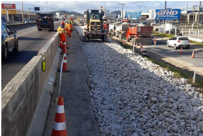
Figura 157 – Execução da sub-base.
