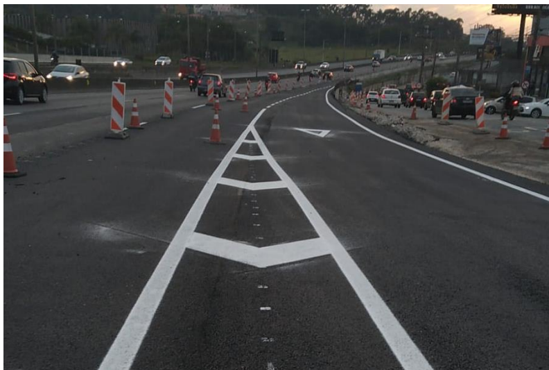
Figura 103 – Sinalização horizontal finalizada.
