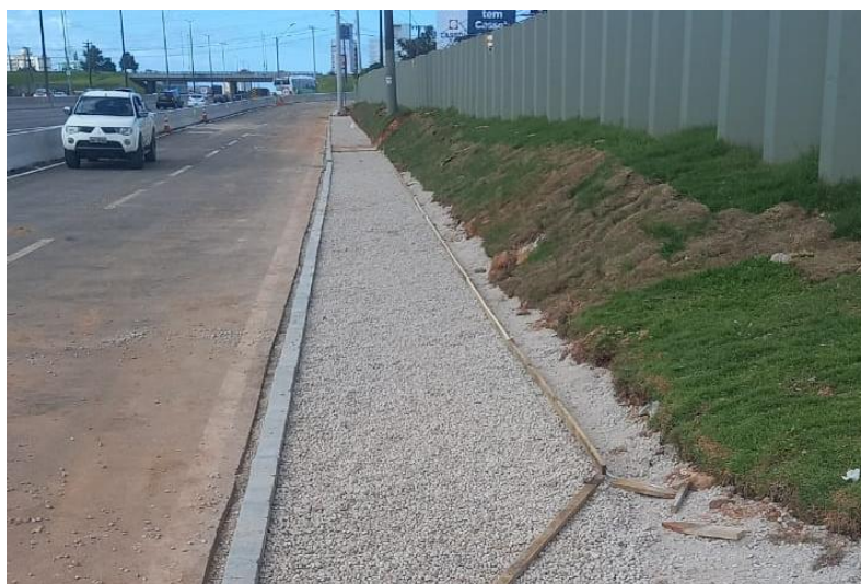
Figura 201 – Execução de passeio.
