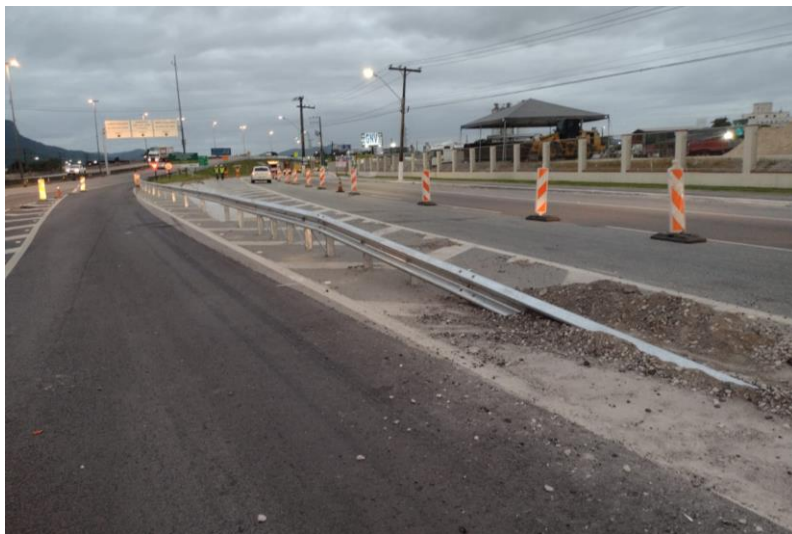
Figura 182 – Instalação de defesa metálica.
