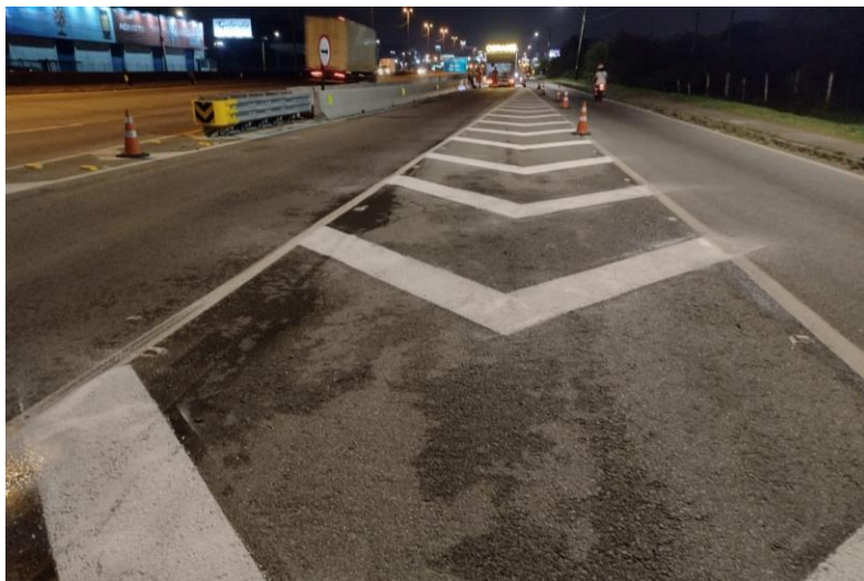
Figura 145 – Pintura sinalização horizontal.
