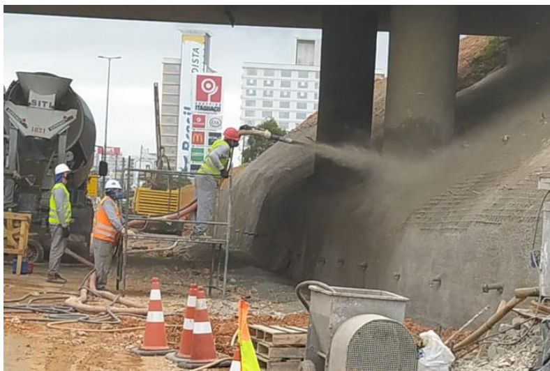
Figura 16 – Concreto projetado muro grampeado – Ramo 100.
