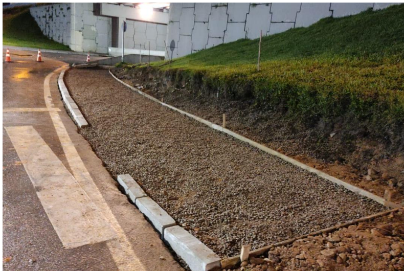
Figura 217 – Execução de passeio.
