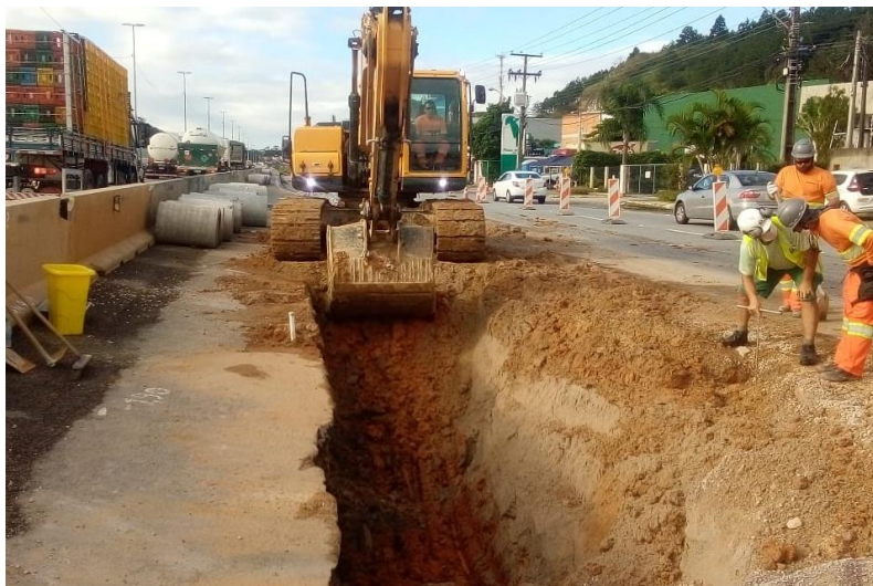
Figura 113 – Início escavação da agulha.
