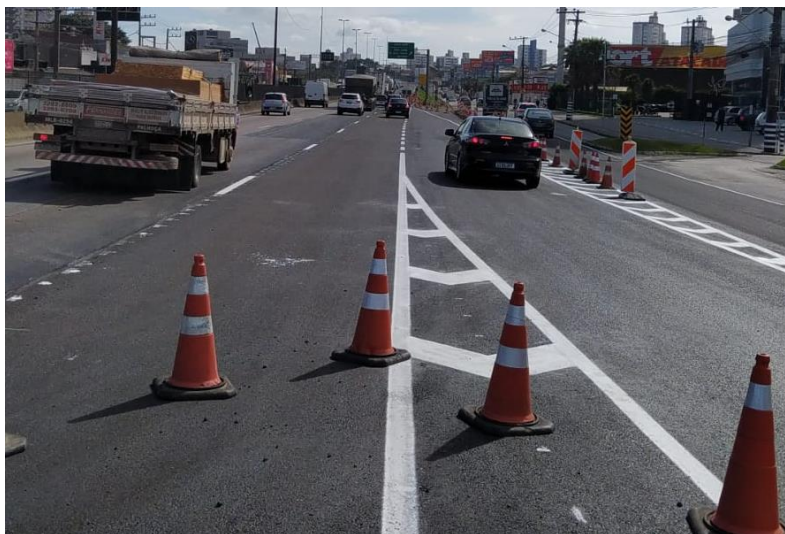
Figura 59 – Pintura sinalização horizontal.
