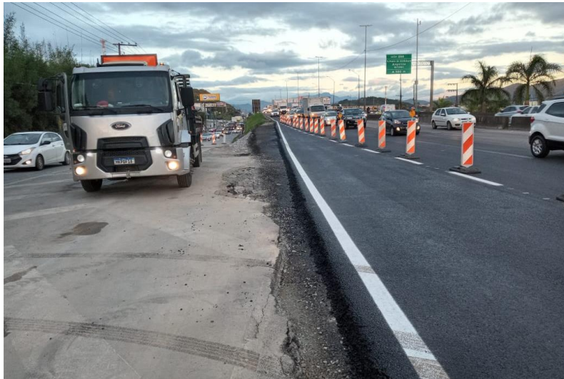
Figura 110 – Pintura sinalização horizontal.
