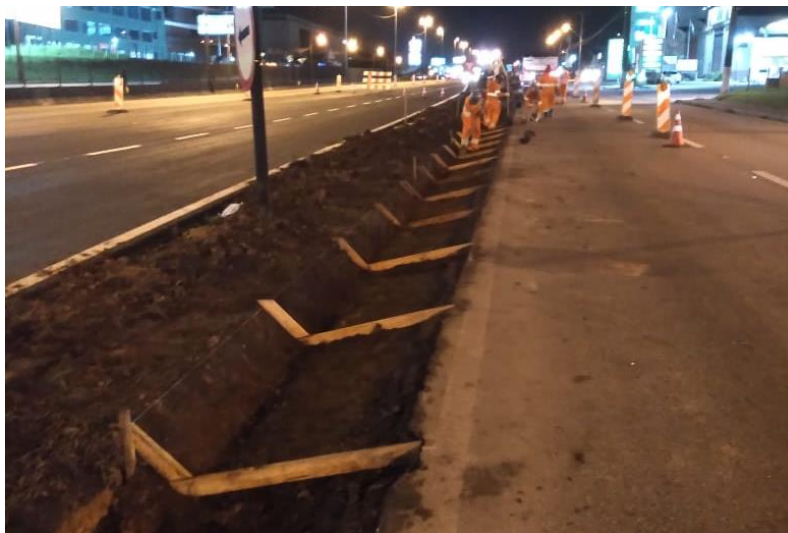
Figura 137 – Preparação de gabarito para sarjeta.
