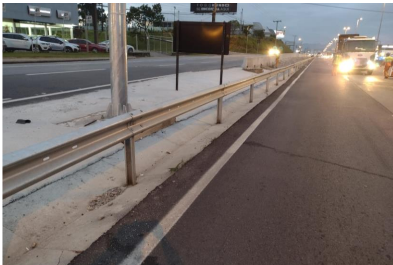
Figura 119 – Instalação de defesa metálica.
