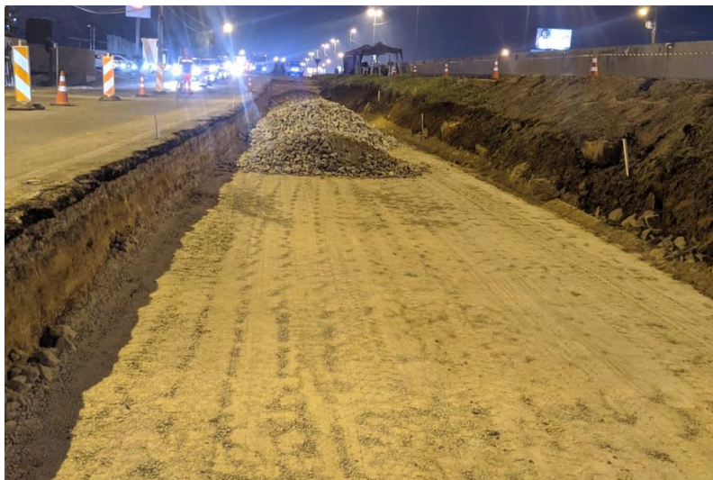
Figura 99– Execução de sub-base: macadame.
