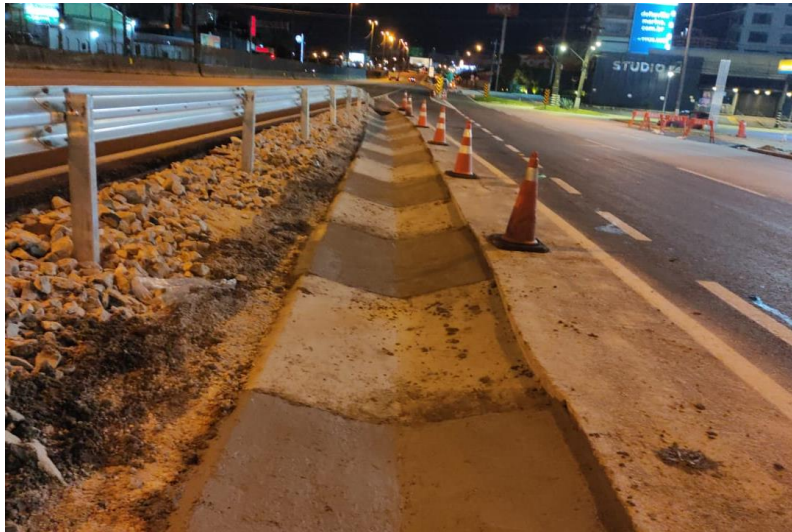
Figura 60 – Concretagem sarjeta.
