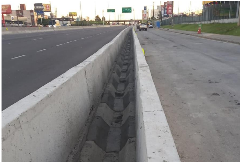
Figura 78 – Execução de sarjeta.
