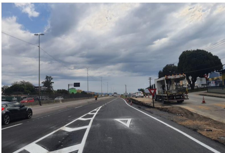
Figura 49 – Pintura sinalização horizontal.
