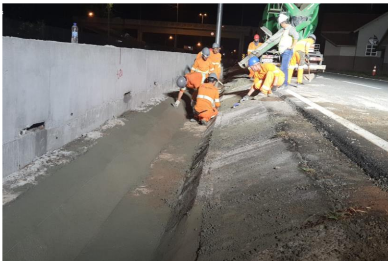
Figura 35 – Execução de sarjeta.
