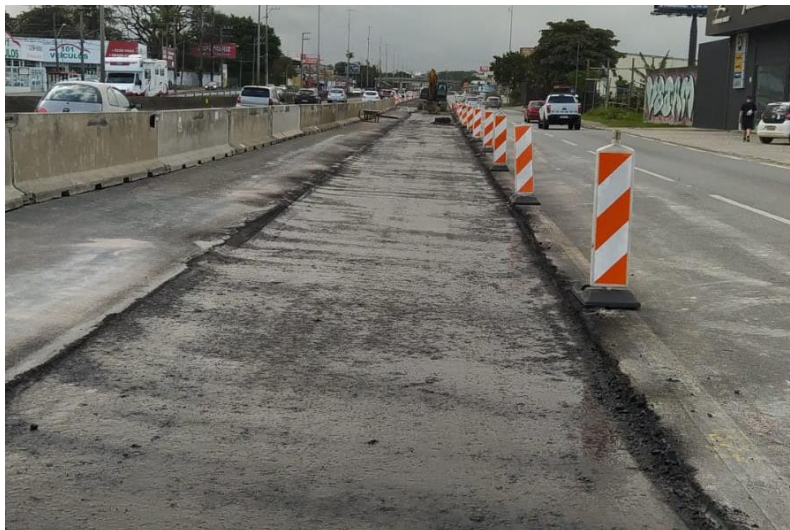
Figura 36 – Aplicação de imprimadura.
