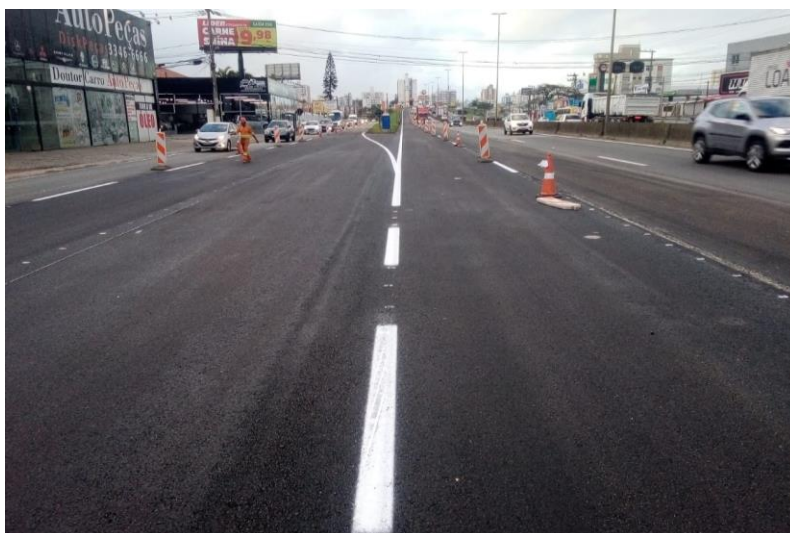
Figura 37 – Pintura sinalização horizontal.
