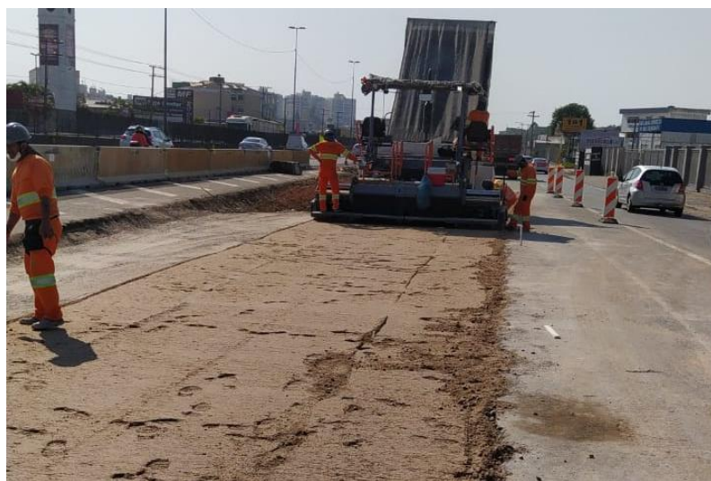
Figura 29 – Camada de travamento.
