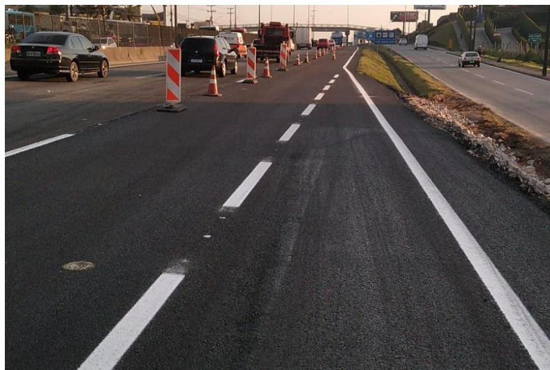
Figura 25 – Sinalização horizontal finalizada.
