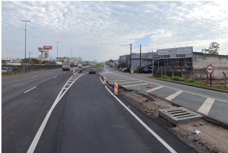
Figura 32 – Sinalização horizontal finalizada.
