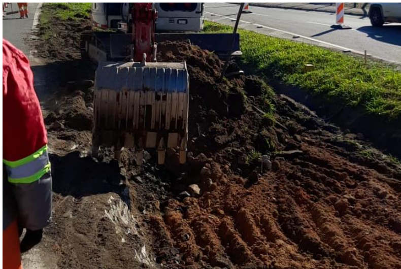
Figura 40 – Início da escavação da agulha.
