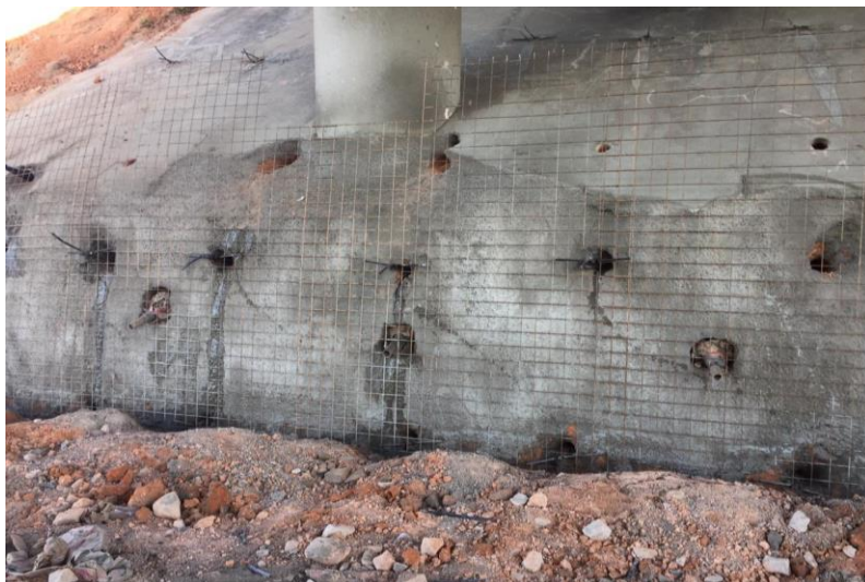
Figura 15 – Grampos e tela muro grampeado – Ramo 100.
