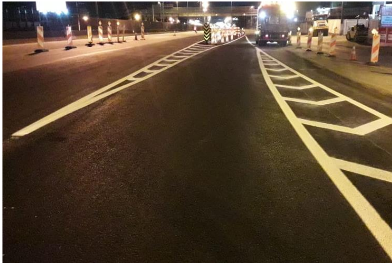
Figura 176 – Pintura sinalização horizontal.
