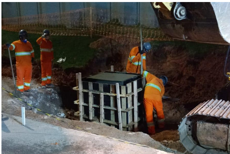
Figura 187 – Concretagem de caixa coletora.
