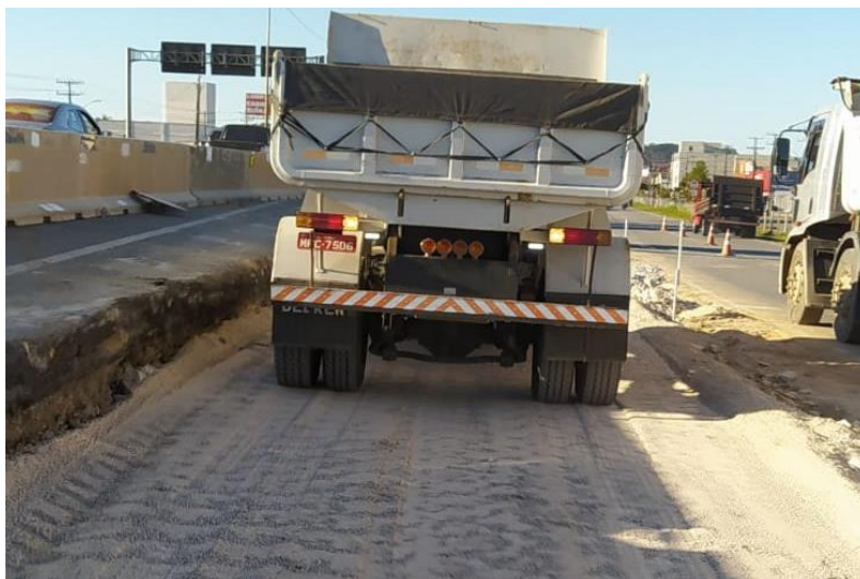
Figura 150 – Execução de sub-base.
