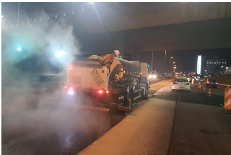
Figura 11- Imprimadura faixa 1 – km 205.
