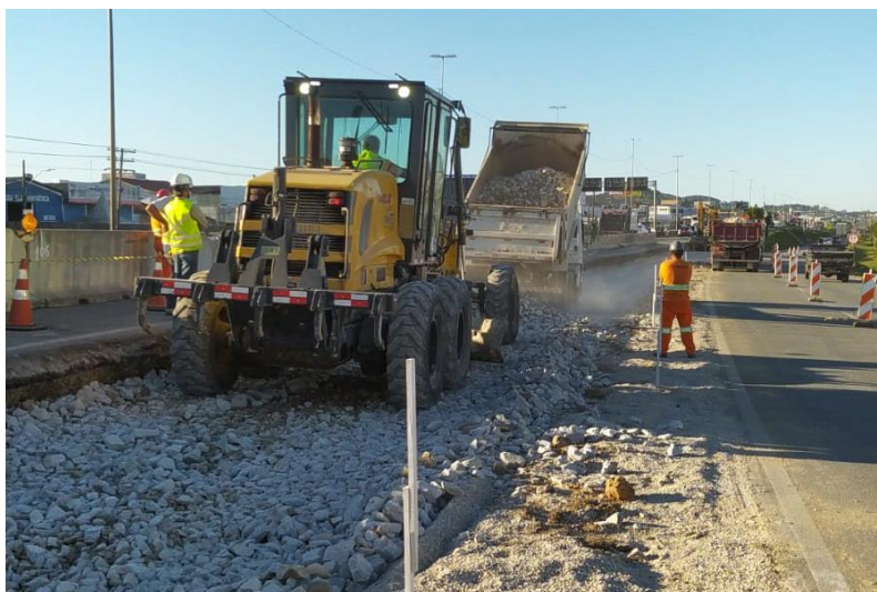
Figura 148 – Execução de sub-base.
