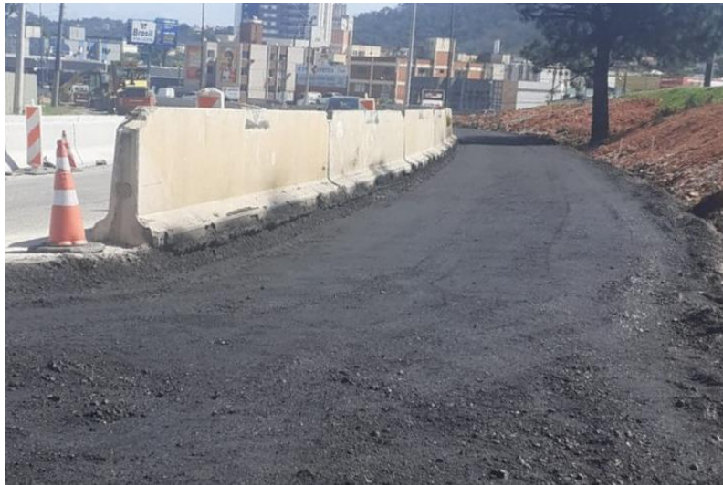
Figura 86 – Base compactada.
