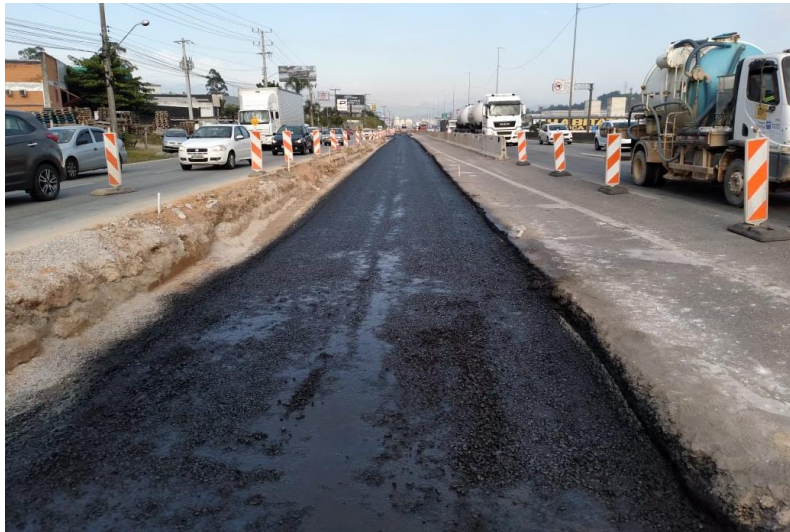
Figura 118 – Aplicação de imprimadura impermeabilizante.
