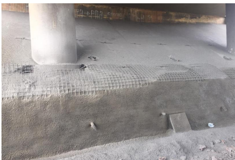
Figura 17 – Finalização do concreto projetado muro grampeado – Ramo 100.
