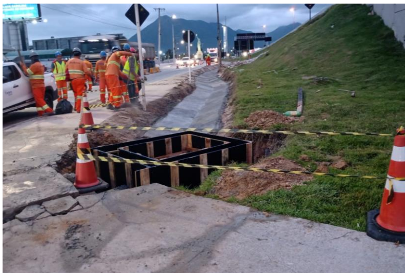
Figura 219 – Execução de caixa coletora.
