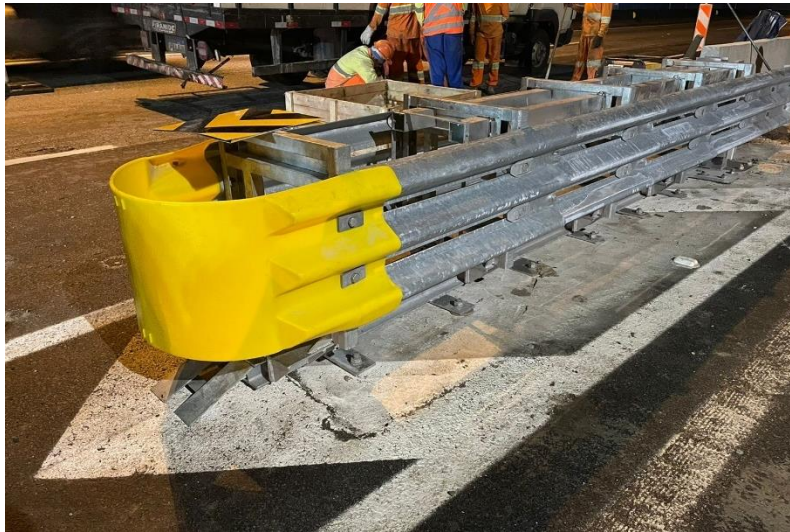
Figura 146 – Atenuador de impacto.
