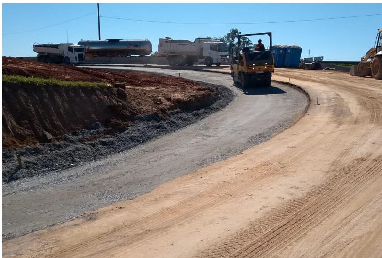
Figura 71 – Compactação da base.
