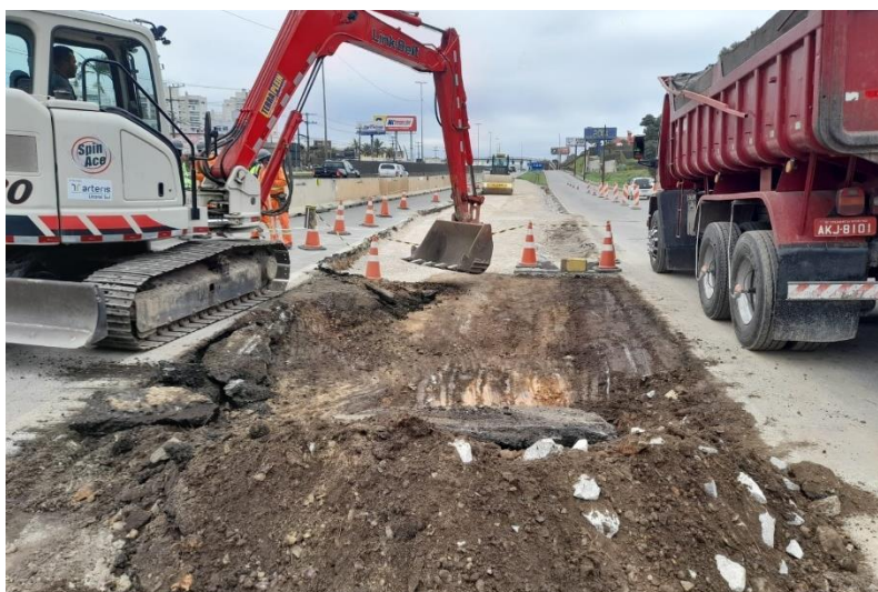
Figura 23 – Início da escavação.
