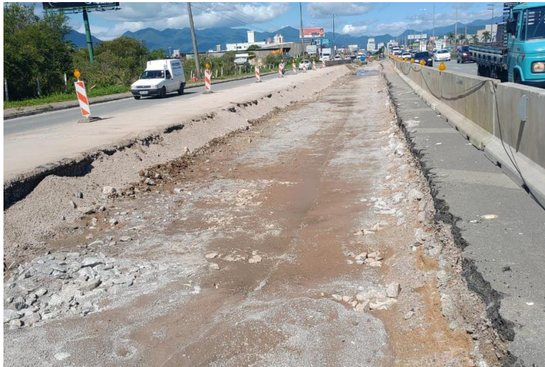
Figura 142 – Execução de sub-base.
