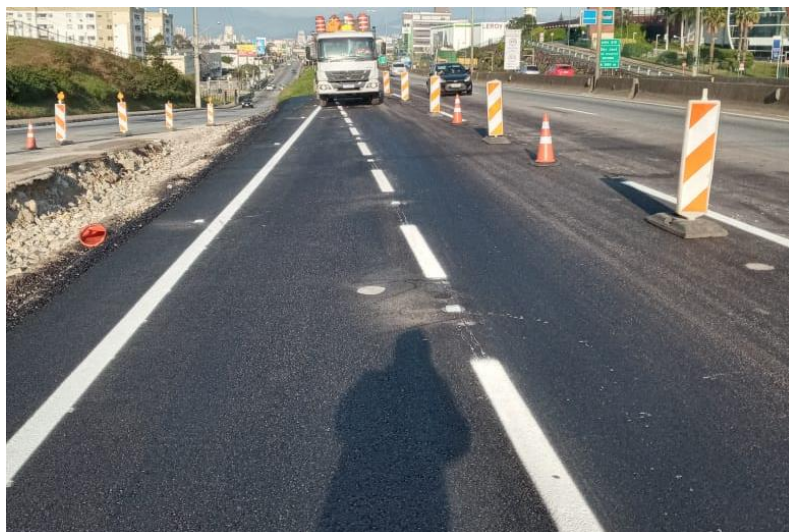
Figura 126 – Sinalização horizontal finalizada.
