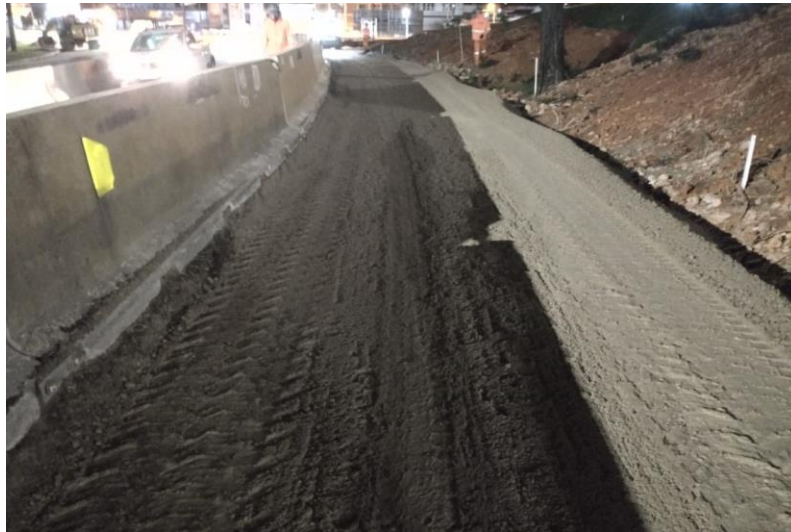
Figura 84– Camada de travamento.
