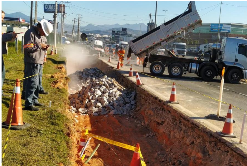
Figura 203 – Execução de sub-base.
