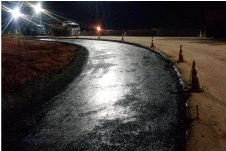
Figura 72 – Aplicação de imprimadura.
