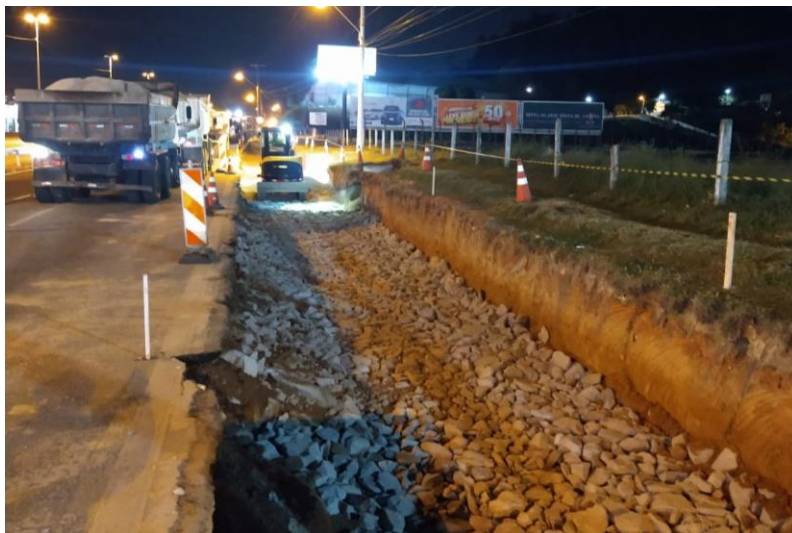
Figura 204 – Execução de sub-base.
