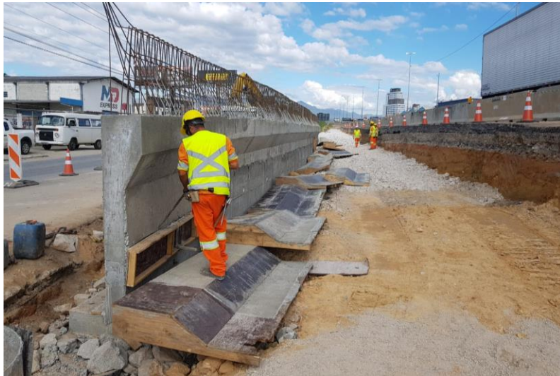
Figura 158 – Execução de barreira.
