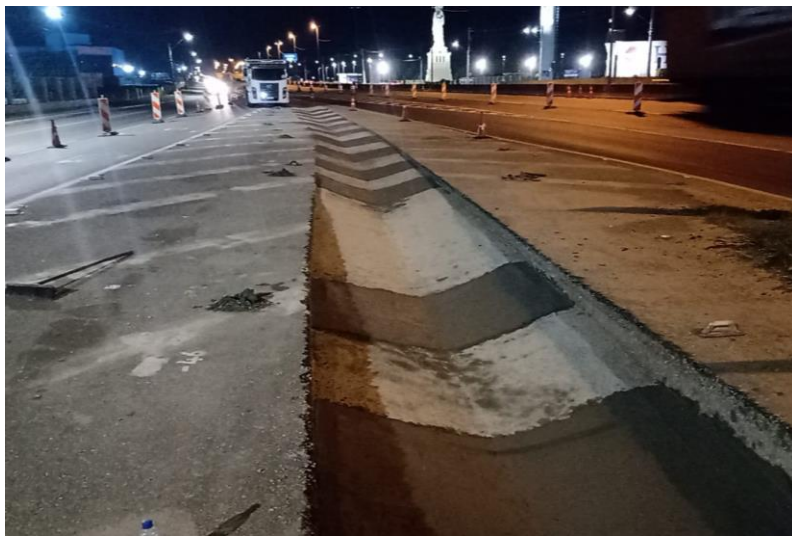
Figura 181 – Concretagem sarjeta.
