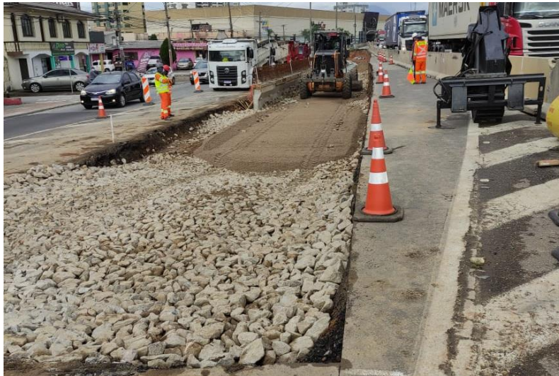
Figura 92 – Camada de travamento e compactação da sub-sabe.
