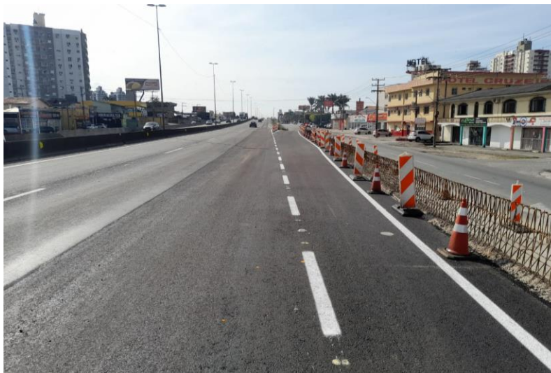
Figura 95– Pintura da sinalização horizontal.
