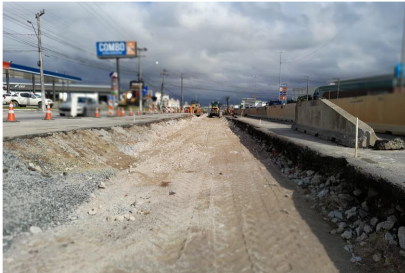
Figura 122 – Execução de sub-base.
