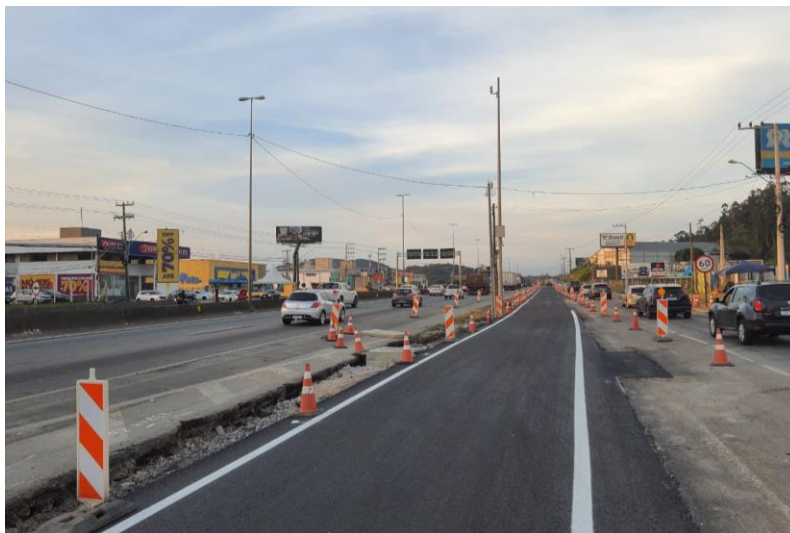
Figura 125 – Sinalização horizontal finalizada.
