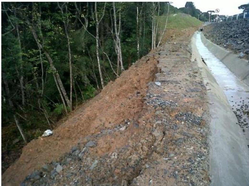
Figura 15 - Estaca 61+00,00 - Vista do Deslizamento do Aterro
