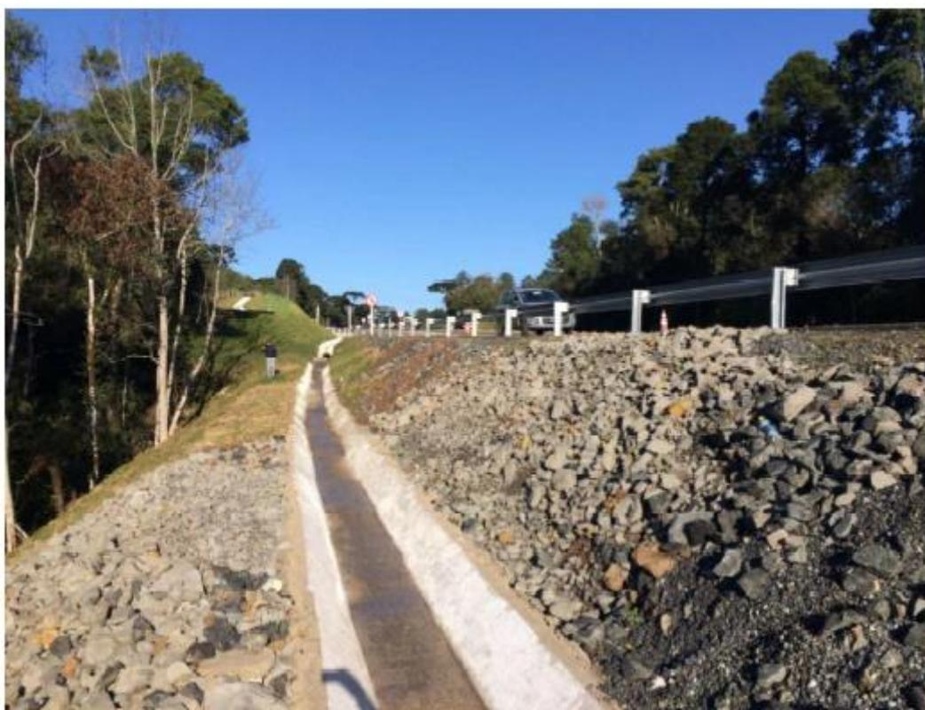
Figura 16 - Local do Deslizamento Recomposto e Valeta de Proteção de Aterro Recuperada
