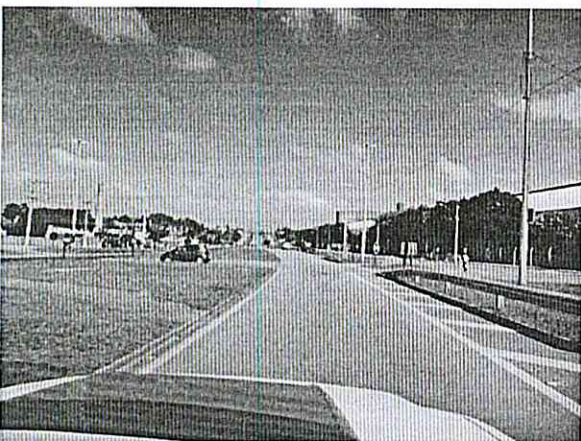
Foto 5 - BR-116/PR/SC – km 209+500 – Pista Sul (8/4/2014)
