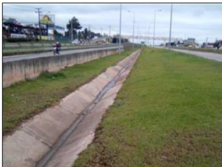
Figura 39 - Drenagem e OAC
