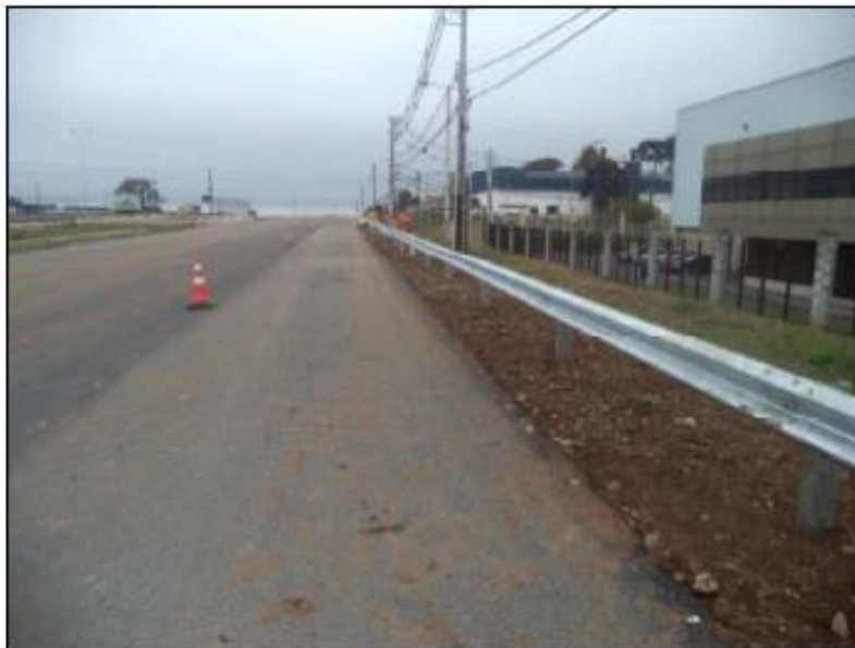
Figura 29 - Execução de Defensas Metálicas
