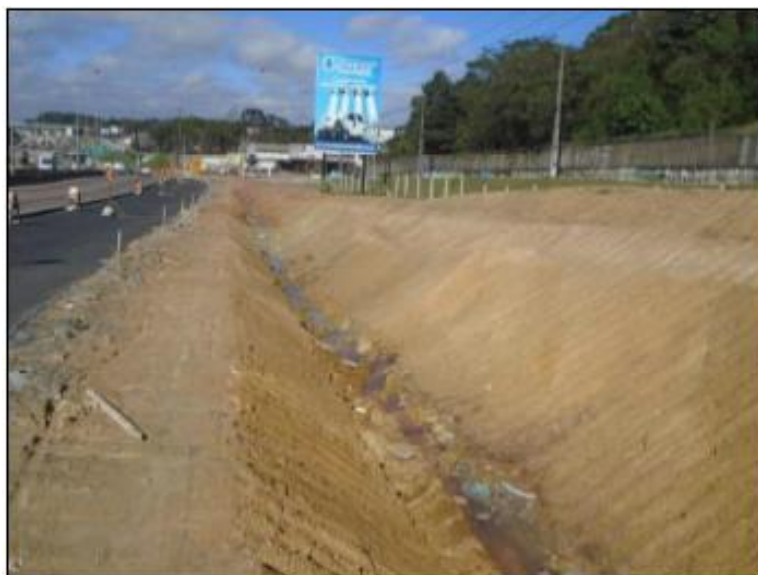
Figura 9 – Execução de Terraplenagem
