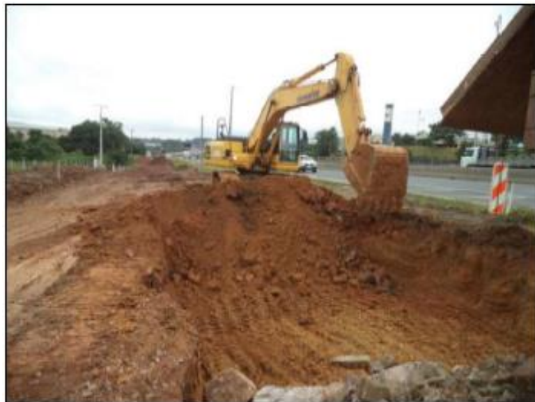
Figura 11 - Execução de Terraplenagem
