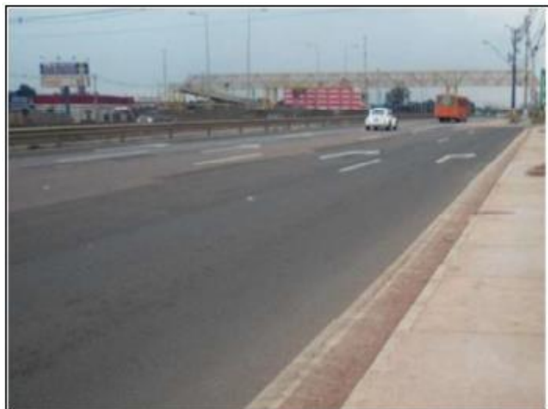
Figura 33 - Vista Geral da Obra
