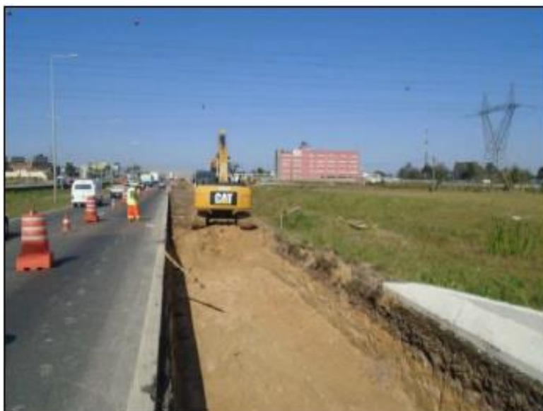
Figura 12 - Execução de Terraplenagem
