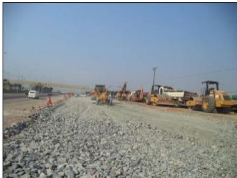
Figura 21 - Execução de Pavimentação
