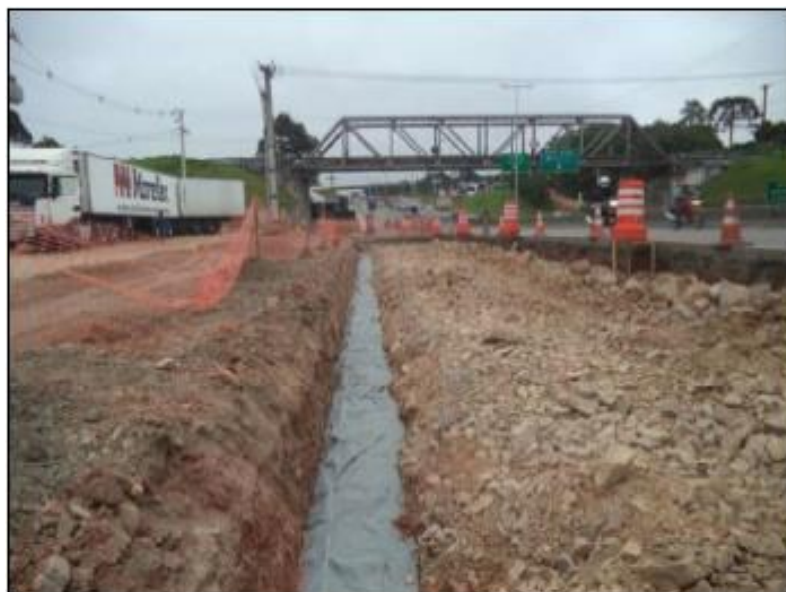
Figura 15 - Execução de Obras de Drenagem
