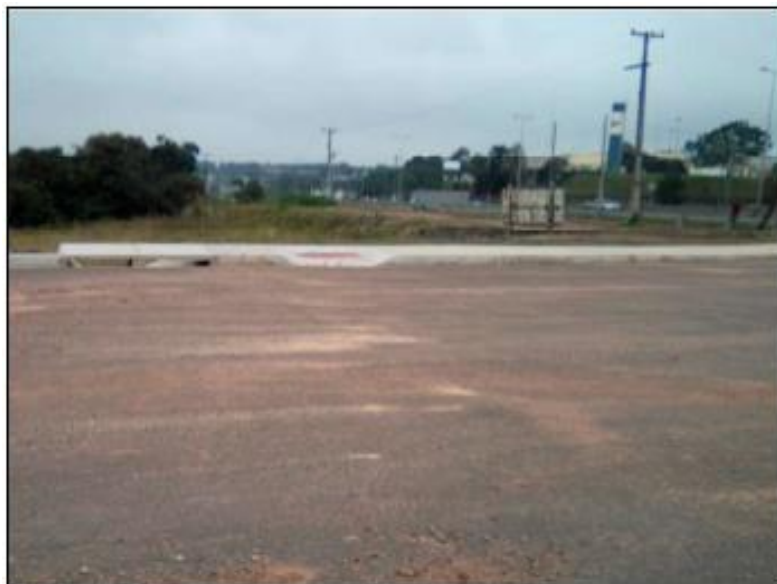
Figura 42 - Drenagem e OAC
