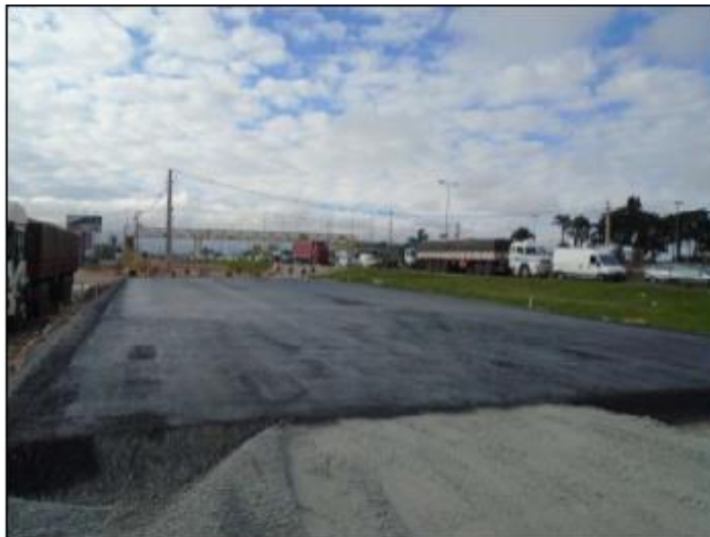
Figura 23 - Execução de Pavimentação
