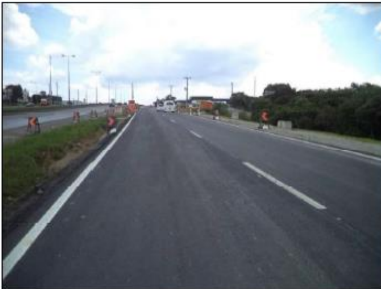
Figura 26 - Execução de Sinalização Horizontal
