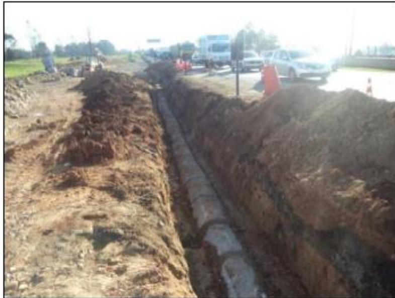
Figura 16 - Execução de Obras de Drenagem
