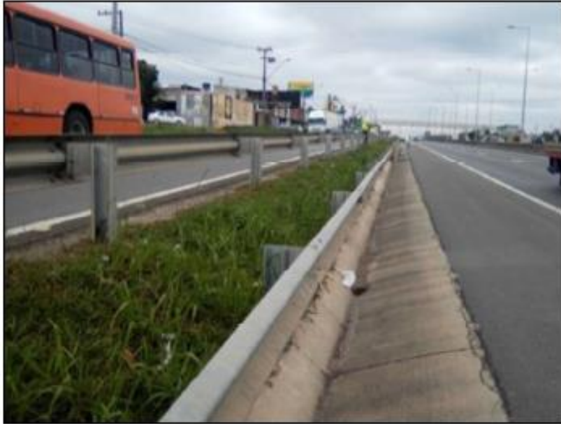
Figura 46 - Defensas Metálicas
