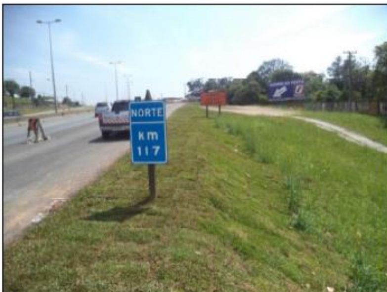
Figura 27 - Execução de Sinalização Vertical
