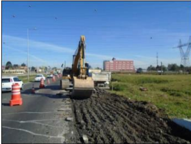
Figura 19 - Execução de Pavimentação
