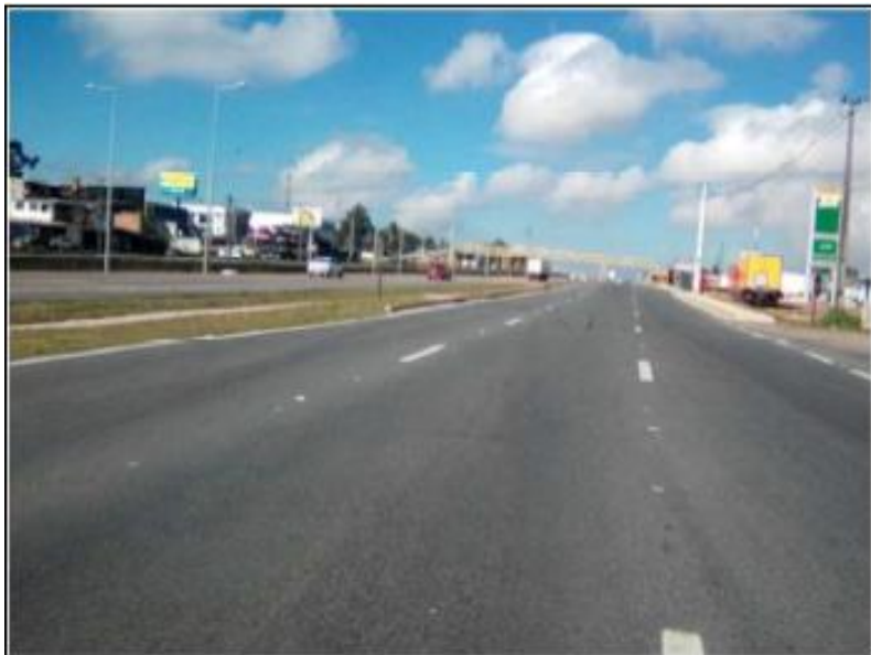
Figura 32 - Vista Geral da Obra
