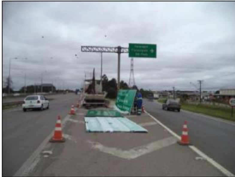
Figura 28 - Execução de Sinalização Vertical
