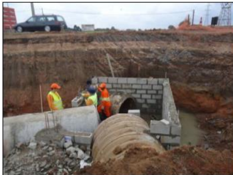
Figura 17 - Execução de Obras de Drenagem
