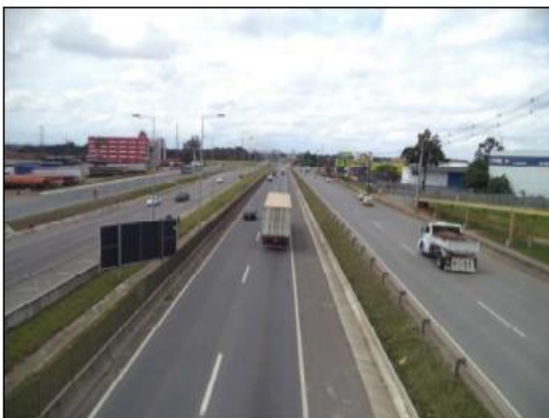
Figura 45 - Sinalização e Defensas Metálicas
