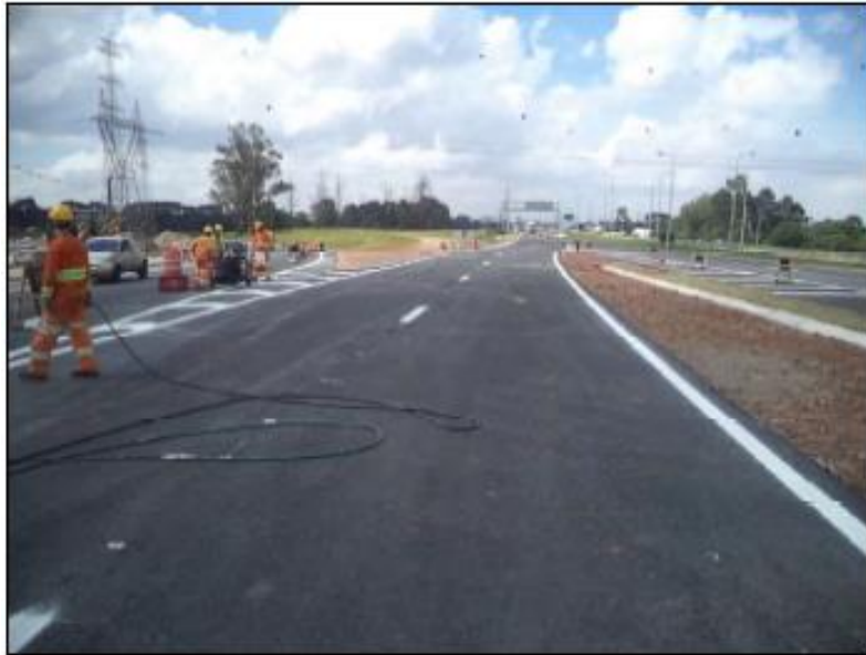
Figura 25 - Execução de Sinalização Horizontal
