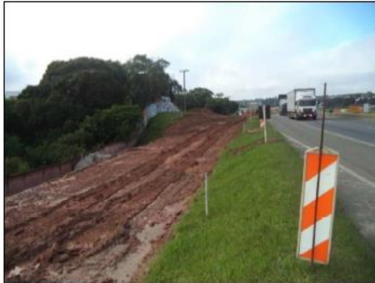
Figura 10 - Execução de Terraplenagem
