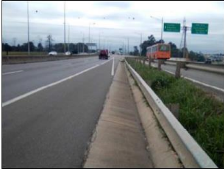
Figura 40 - Drenagem e OAC
