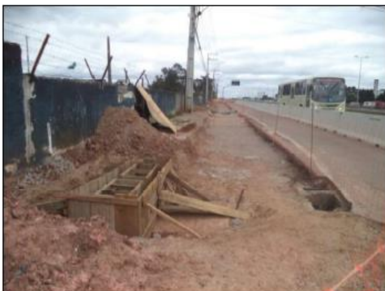
Figura 18 - Execução de Obras de Drenagem
