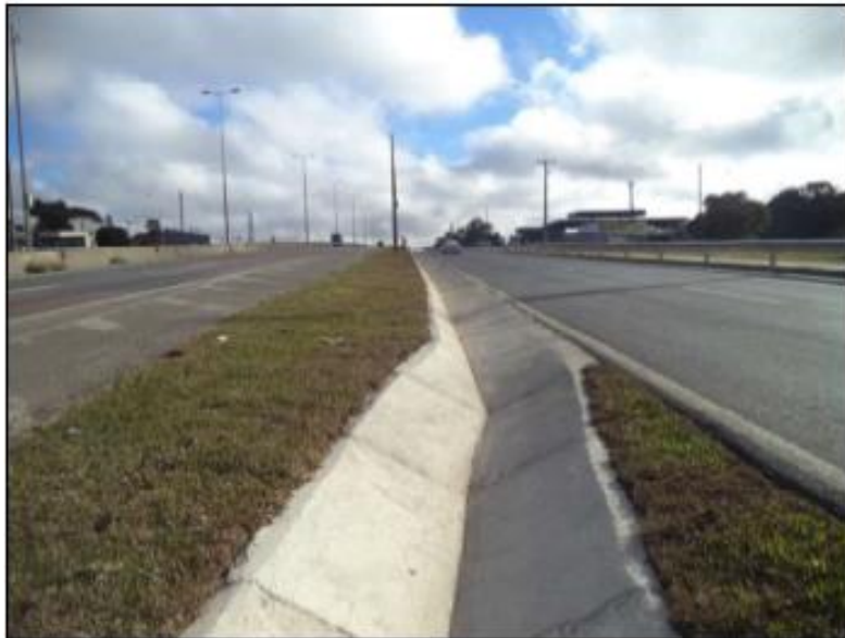
Figura 41 - Drenagem e OAC
