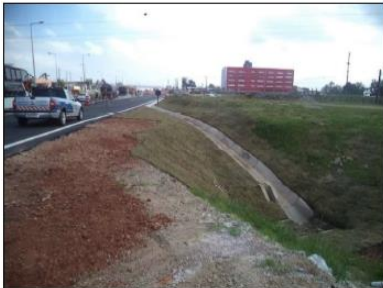
Figura 14 - Execução de Obras de Drenagem
