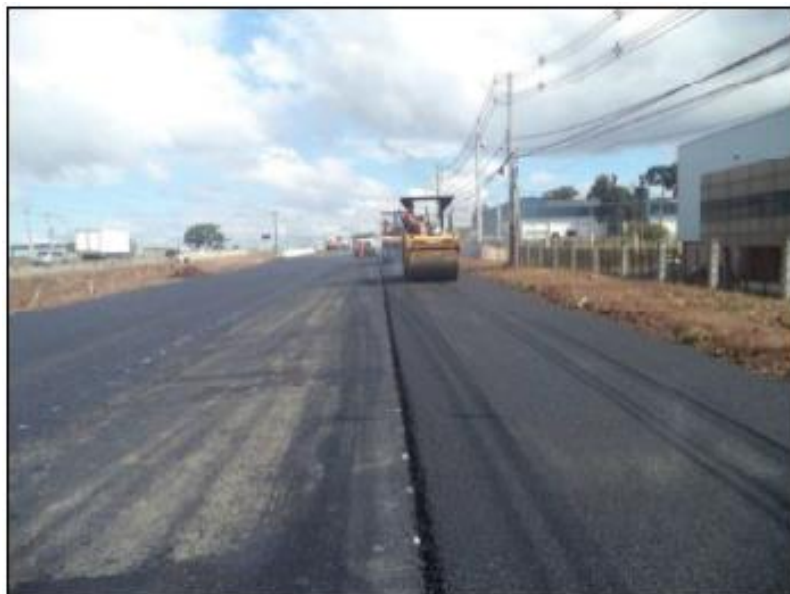
Figura 24 - Execução de Pavimentação
