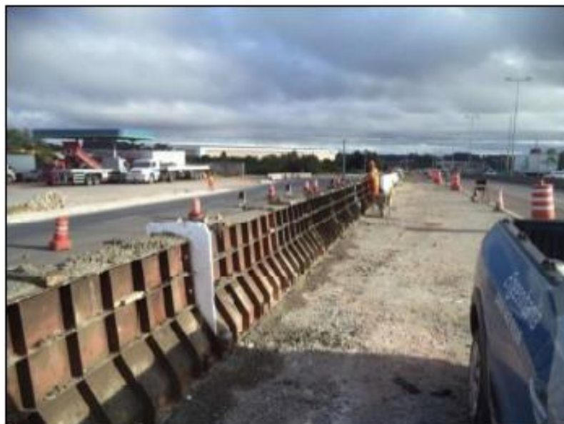
Figura 30 - Execução de Barreiras de Concreto
