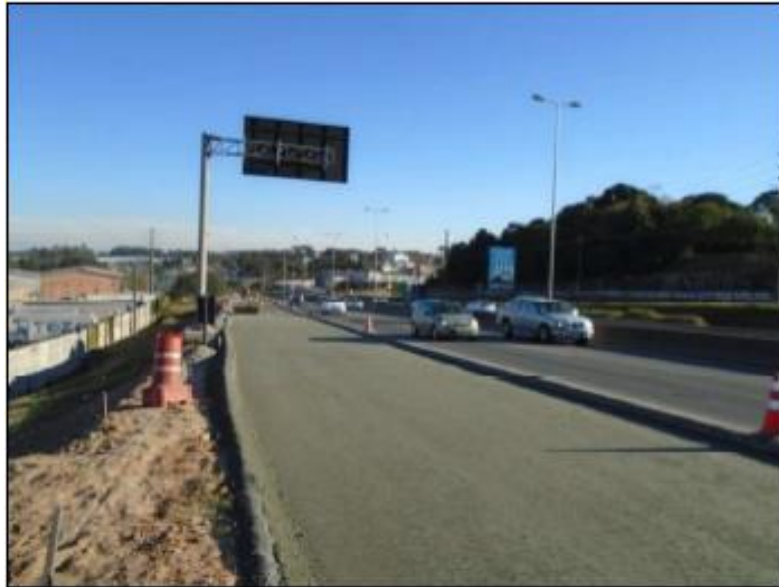
Figura 22 - Execução de Pavimentação
