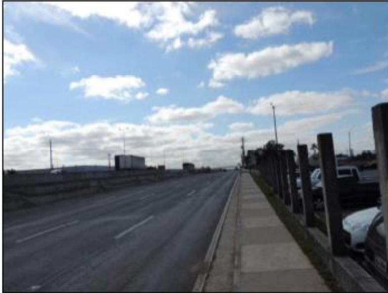
Figura 34 - Vista Geral da Obra
