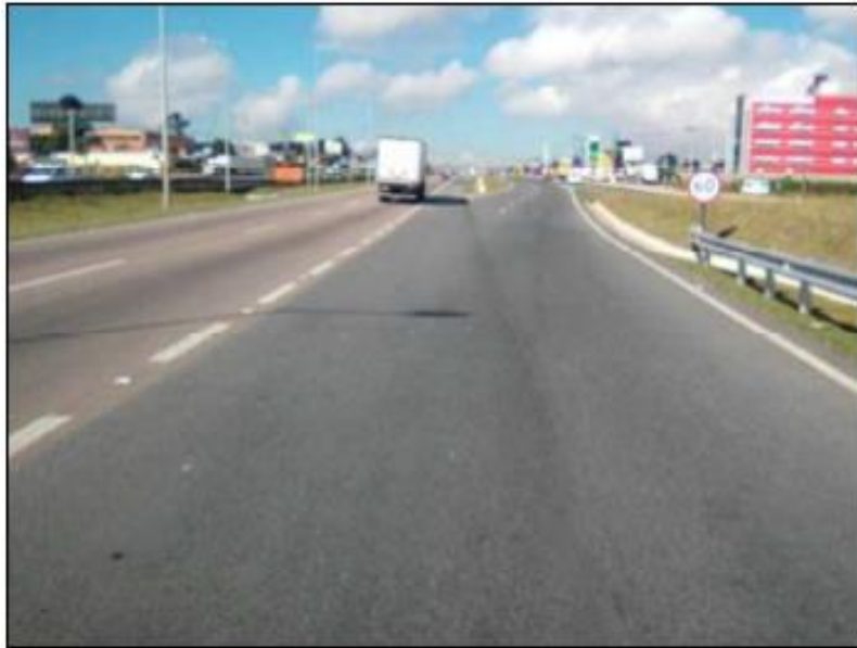
Figura 31 - Vista Geral da Obra
