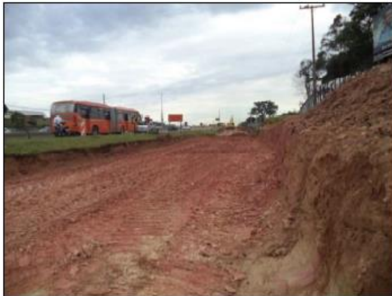
Figura 20 - Execução de Pavimentação
