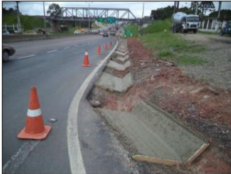
Figura 13 - Execução de Obras de Drenagem
